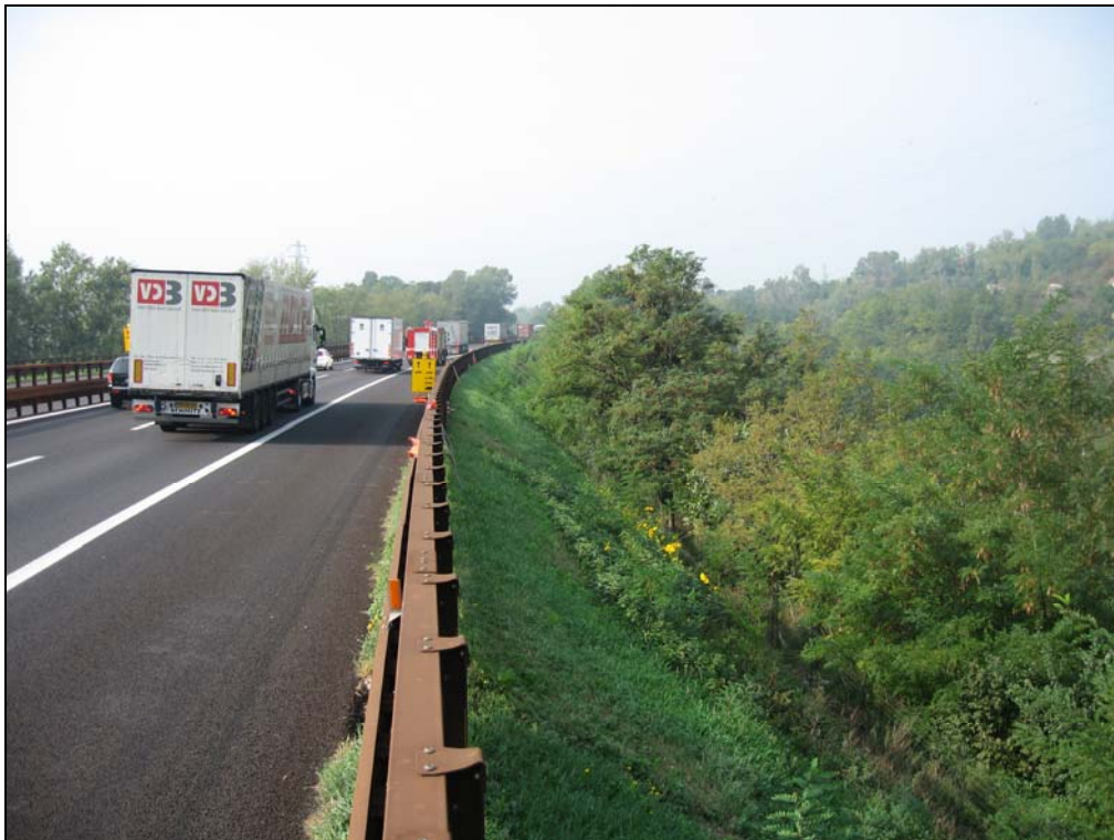
FOTO 2: Panoramica del primo tratto in rilevato
