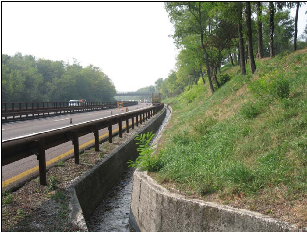
FOTO 10: Particolare canalette esistenti
