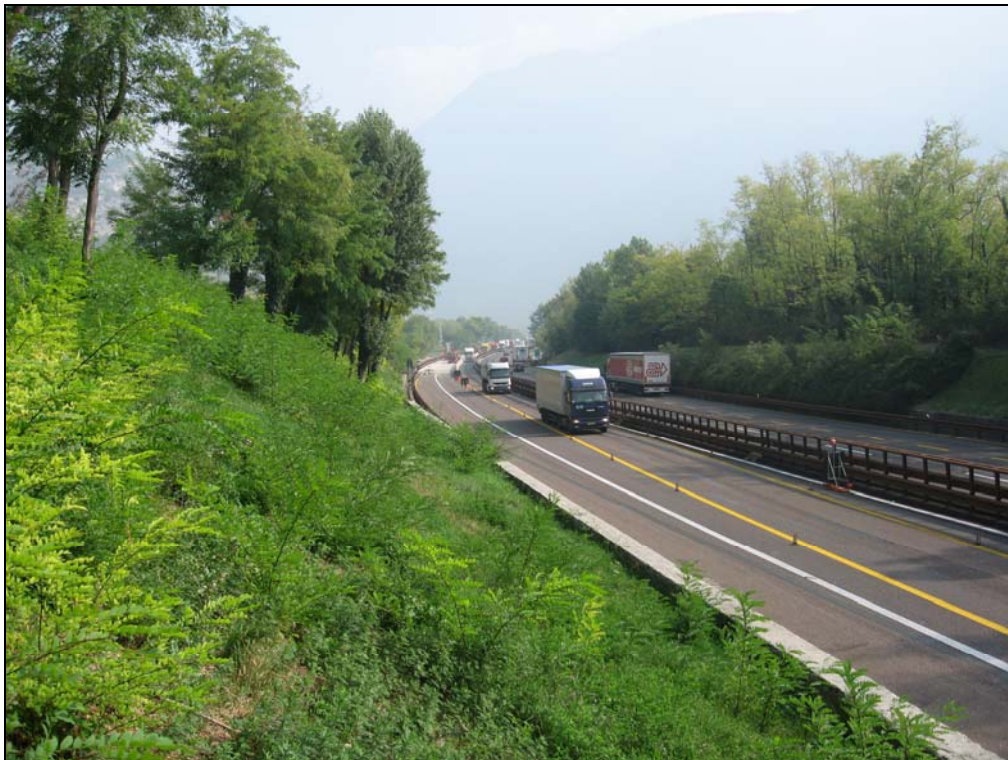
FOTO 6: Panoramica dei tratti con allargamento in trincea (scogliera 2/3)
