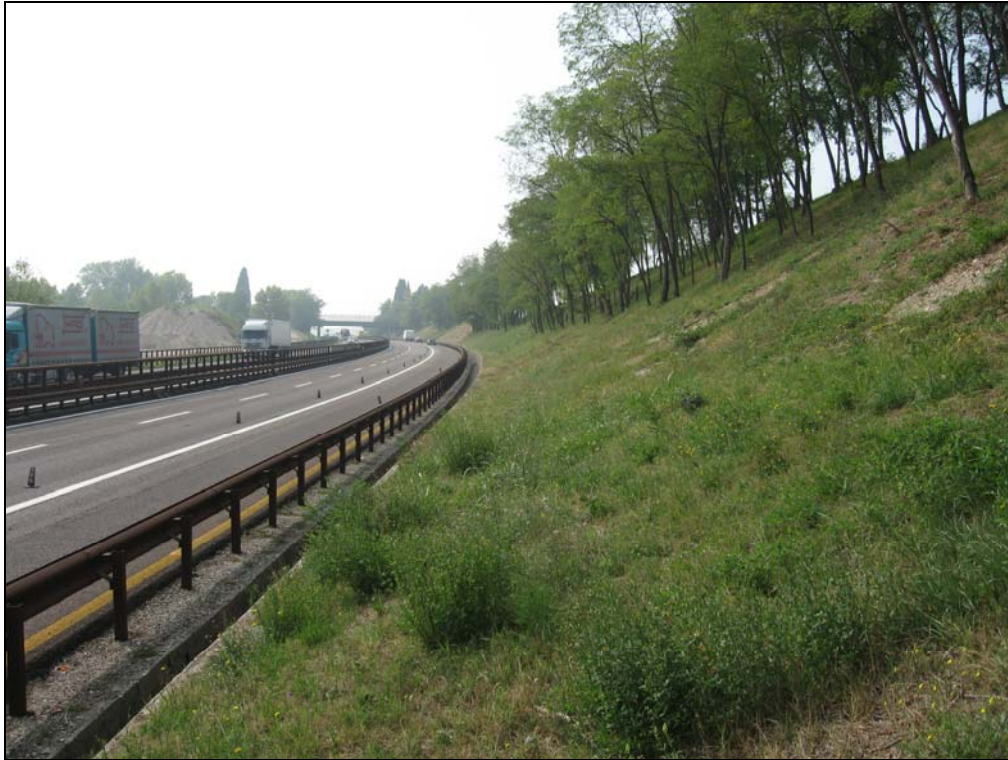
FOTO 9: Panoramica dei tratti con allargamento in trincea (scogliera 2/3)
