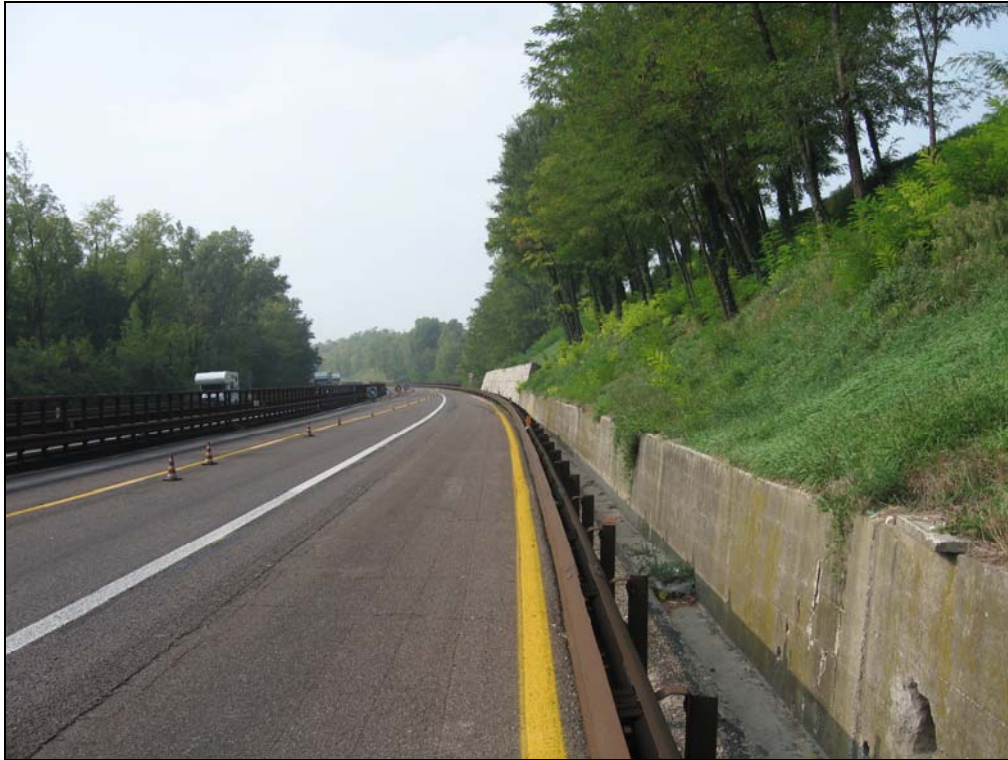
FOTO 5: Panoramica dei tratti con allargamento in trincea (scogliera 2/3)
