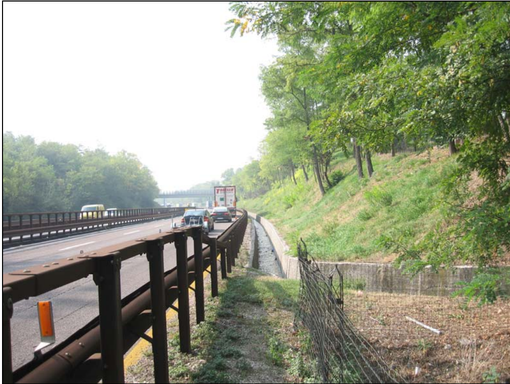
FOTO 7: Panoramica dei tratti con allargamento in trincea (scogliera 2/3)
