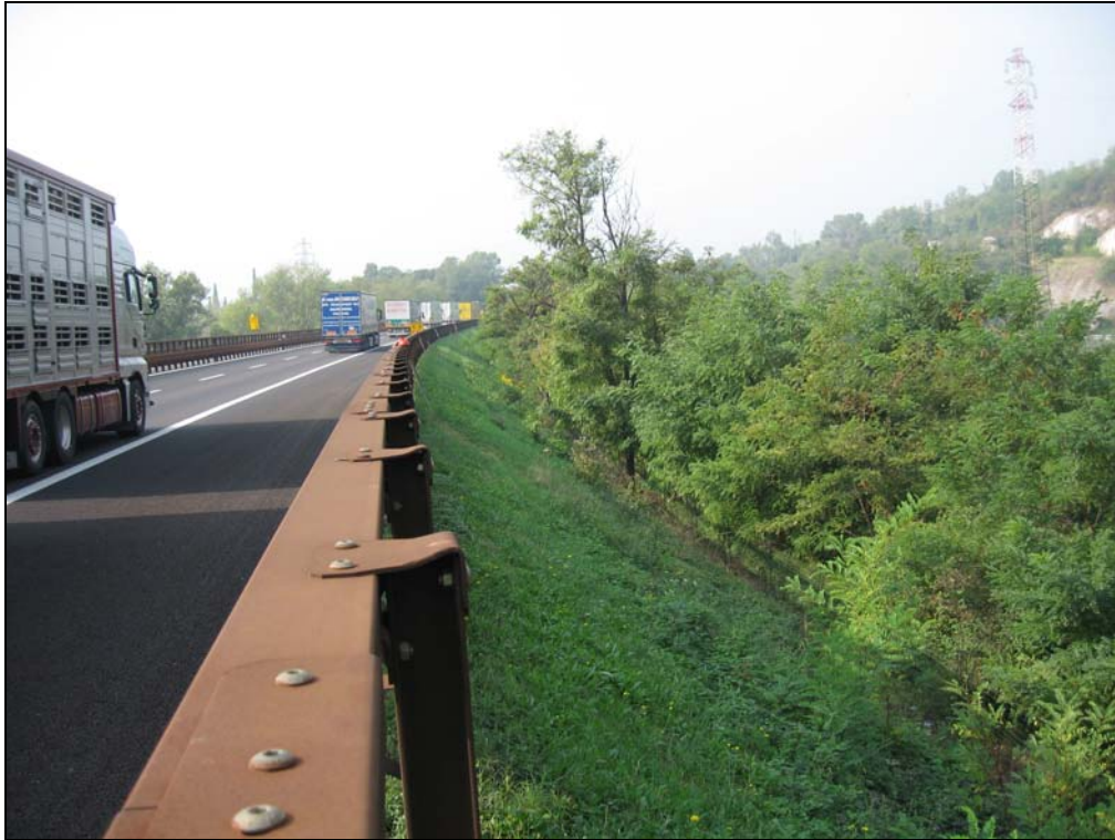
FOTO 1: Panoramica del primo tratto in rilevato
