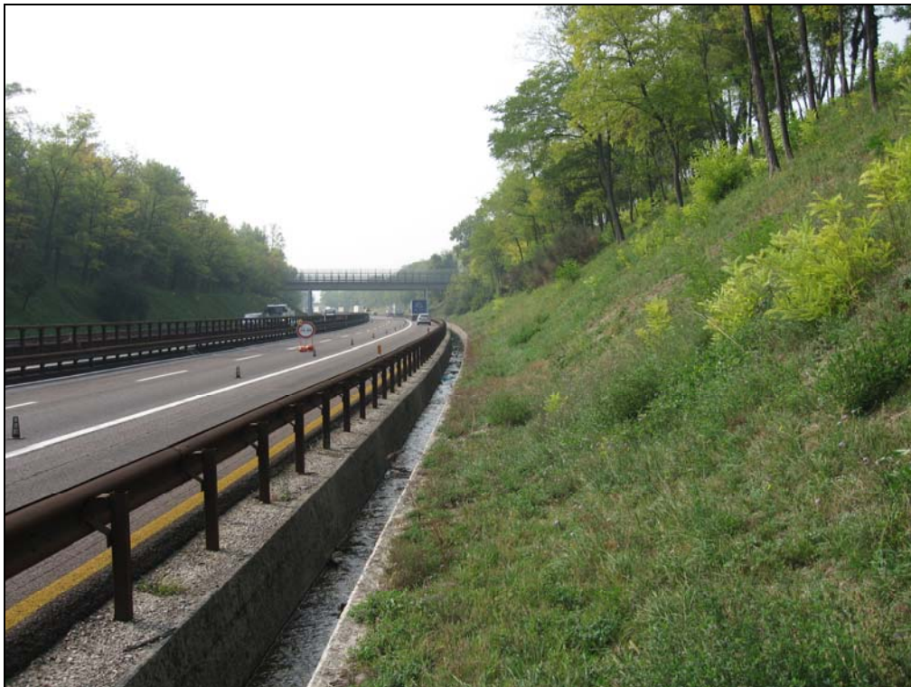
FOTO 8: Panoramica dei tratti con allargamento in trincea (scogliera 2/3)
