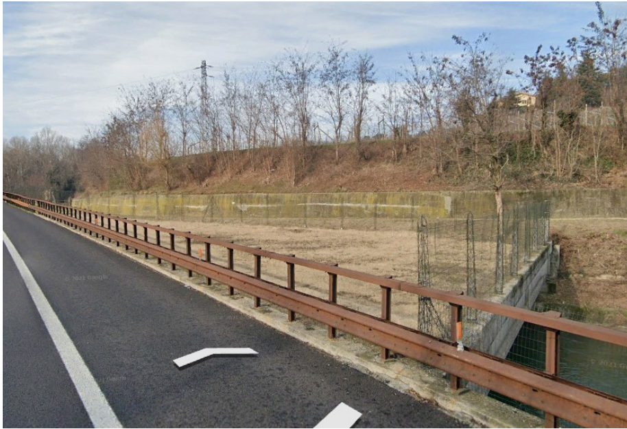
Immagine del muro esistente, oggetto in parte di demolizione (Google Streetview)
