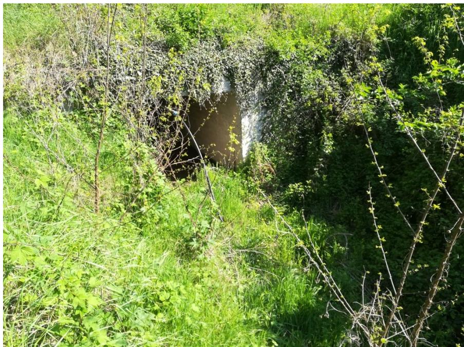
Da questo punto in poi lo scarico prosegue per qualche metro a sezione naturale per confluire in una tubazione in lamiera ondulata tipo Finsider del diametro interno di 1.40 m che sotto passa la pista ciclabile che si snoda in fregio al fiume Adige (in dx orografica), per terminare poi in Adige. La lunghezza di tale tubazione è di circa 15 m e presenta una pendenza del 5 % circa.
