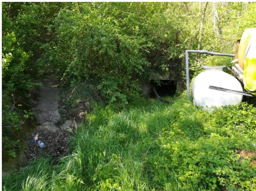
L'attraversamento della carreggiata autostradale (progressiva 201+600) è costituito da un manufatto cemento armato delle dimensioni di 2.00 x 2.00 il cui sbocco di valle è quello della fotografia seguente. Tale manufatto ha una lunghezza di circa 90.00 m ed una pendenza del 1.11 %.
