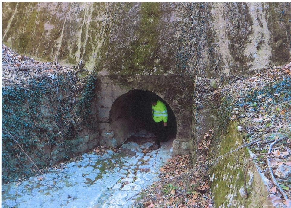
La lunghezza di tale attraversamento è di poco superiore ai 90 m e presenta una pendenza longitudinale del 4.60 %. Da questo punto in poi l'impluvio si sviluppa a sezione naturale ben definita ed incassata fino allo sbocco in Adige. Poco prima dello sbocco la Valle Grande incrocia, in corrispondenza della pista ciclabile (strada delle Fornaci), l'impluvio della Valle Piccola (bacino 2). Lo sbocco in Adige è a quota di 95 m s.l.m. (vedi estratto disegni tecnici seguenti-Fonte: Hydrodolomiti).
