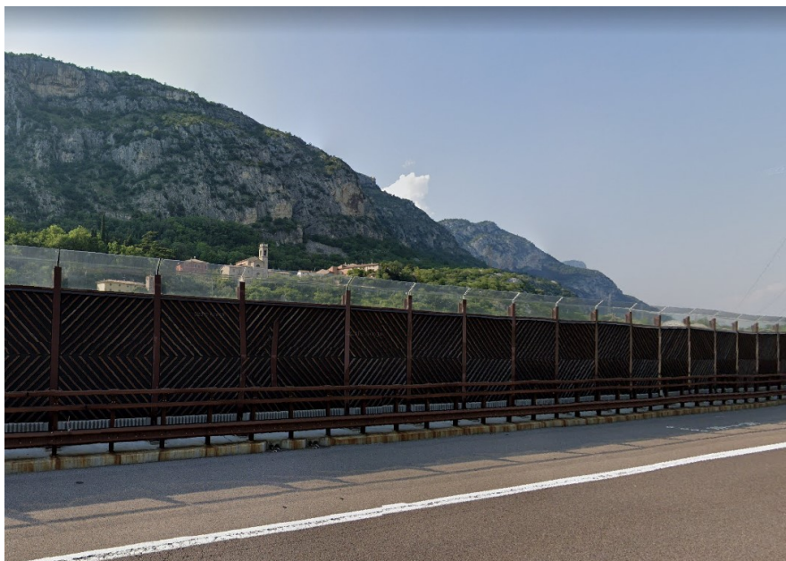
Figura 1.30 Impianto fonoassorbente già installato a protezione dell'abitato di Canale (vista da sud verso nord)
