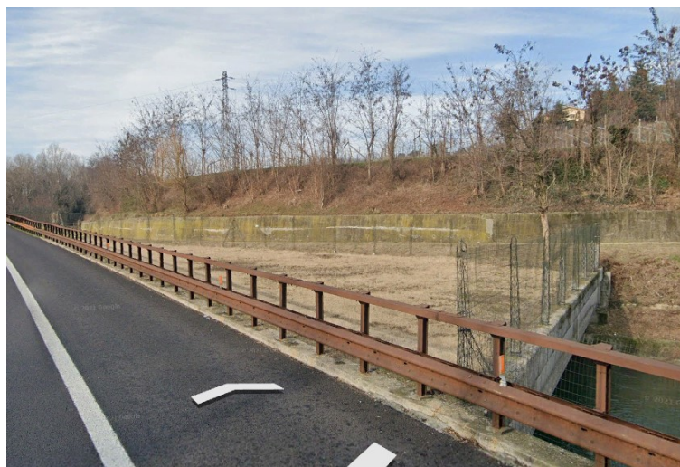
Figura 1.21 Immagine del muro esistente, oggetto in parte di demolizione (Google Streetview)
