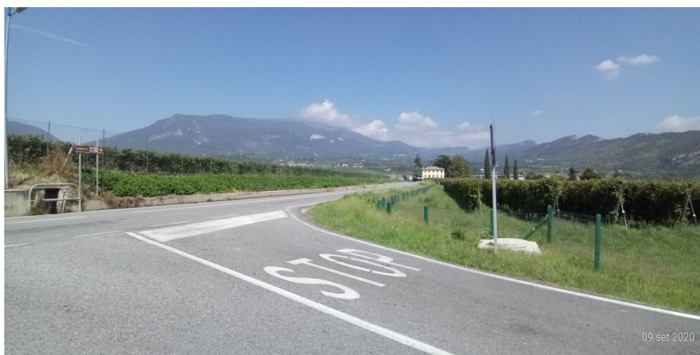
Fig. 30. Incrocio e tratto stradale della S.P. 11. Si notano le balze artificiali con il terreno a vigneto a destra (est) più basso rispetto alla superficie stradale attuale
