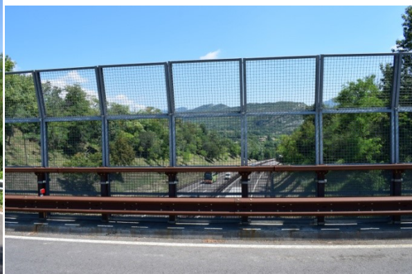
Fig. 6. La trincea autostradale vista dal SVP 68
