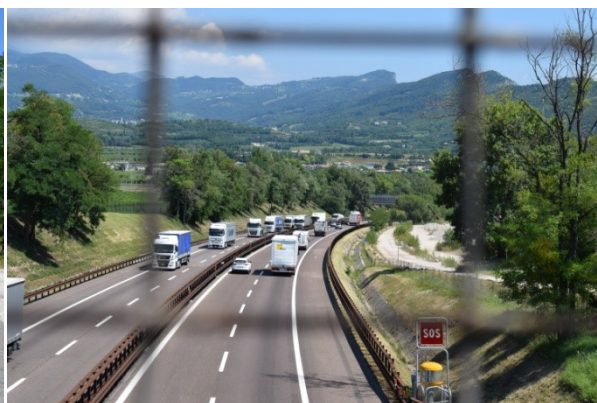
Fig. 14. La trincea autostradale vista dal SVP 69
