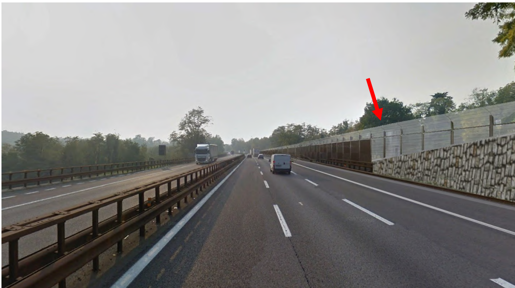
Vista 6: Vista da A22 (circa km 202) stato attuale e simulazione con allargamento carreggiata sud, nuovo guardrail e barriera acustica
