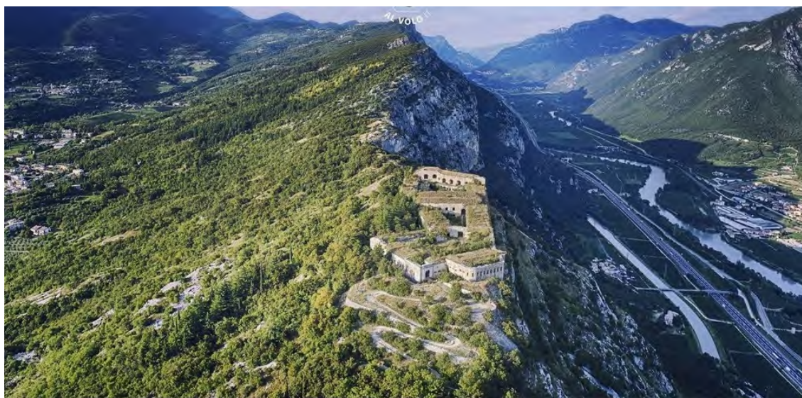
Figura 6: Vista del Forte San Marco 7
