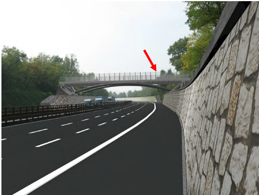
Vista 7: Vista da Nord del Sovrappasso n. 68 circa al km 203 – stato attuale e simulazione con nuova opera, allargamento e muro di sostegno con finitura in pietra
