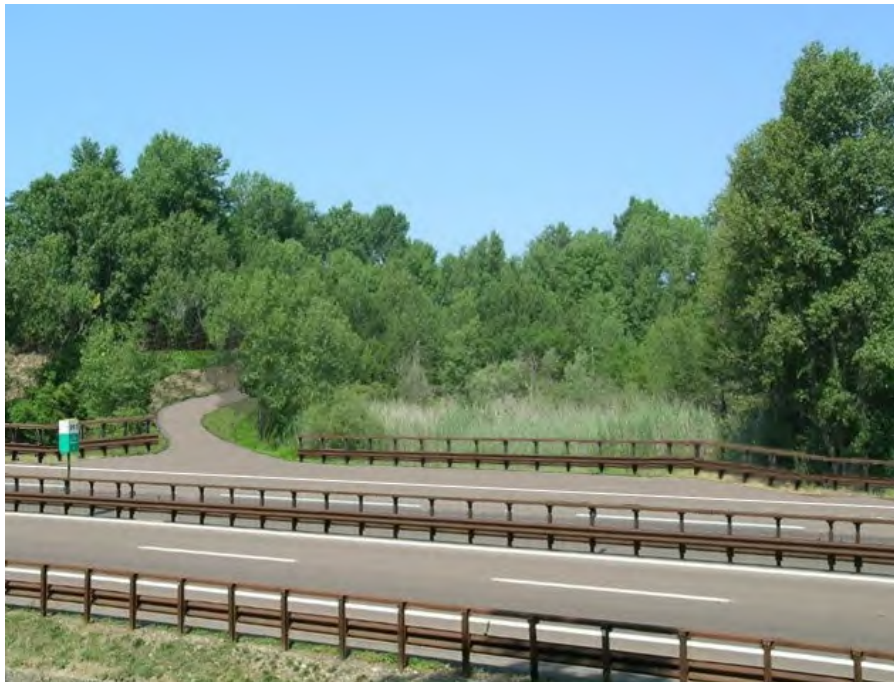
Vista 8: Area umida (km 203+000) – stato attuale e simulazione con nuova pista e piazzola di sosta
