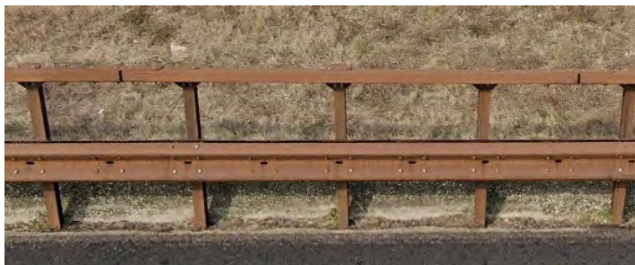
Figura 37: Sicurvia tipo in acciaio Corten già utilizzato lungo il tracciato dell'A22
