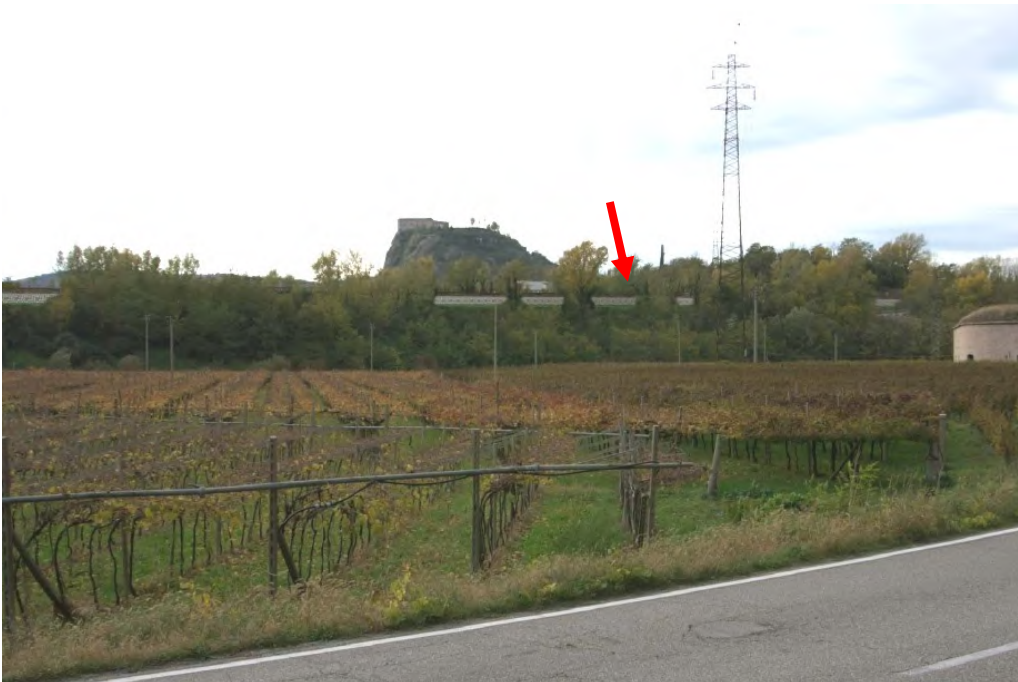
Vista 1: Vista A22 dalla S.S. 12 dell'Abetone e del Brennero nei pressi del forte Tagliata di Canale stato pre e post intervento (muro di sostegno in pietra)
