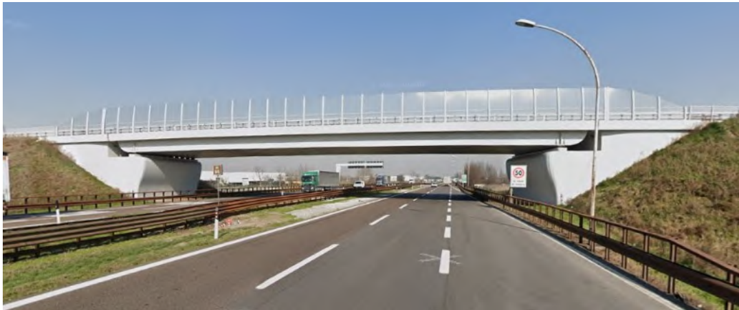
Figura 45: Sovrappasso già realizzato su A22 presso Nogarole Rocca con la stessa finitura delle travi e delle protezioni laterali proposta per i nuovi sovrappassi n. 68 e n. 69 (travi e montanti di acciaio verniciati con una tonalità di grigio RAL 7047 e pannelli di PMMA trasparente).
