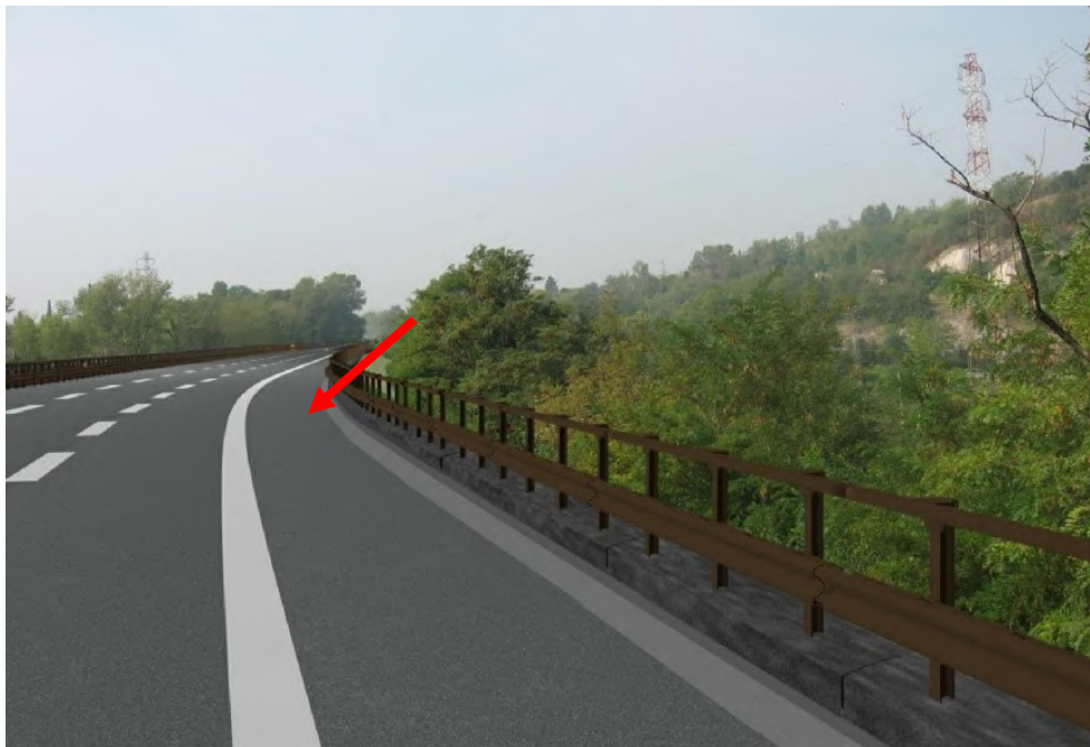
Vista 5: Vista da A22 da inizio intervento (circa km 201+400) stato attuale e simulazione con allargamento carreggiata sud, canaletta alla francese e nuovo guardrail
