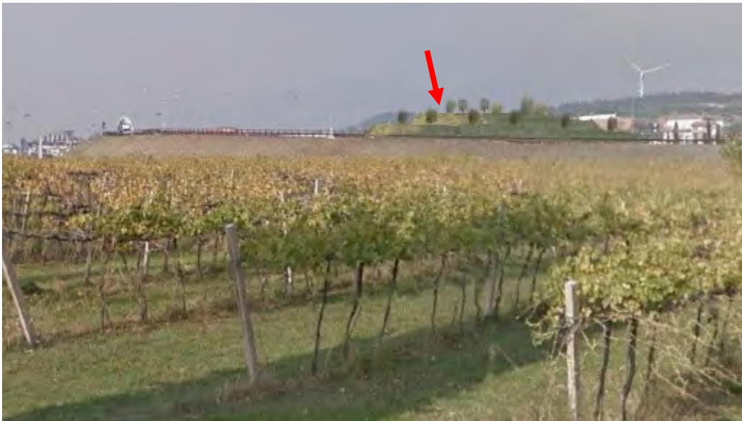
Vista 4: Vista SVICOLO Affi da Nord pre e post intervento
