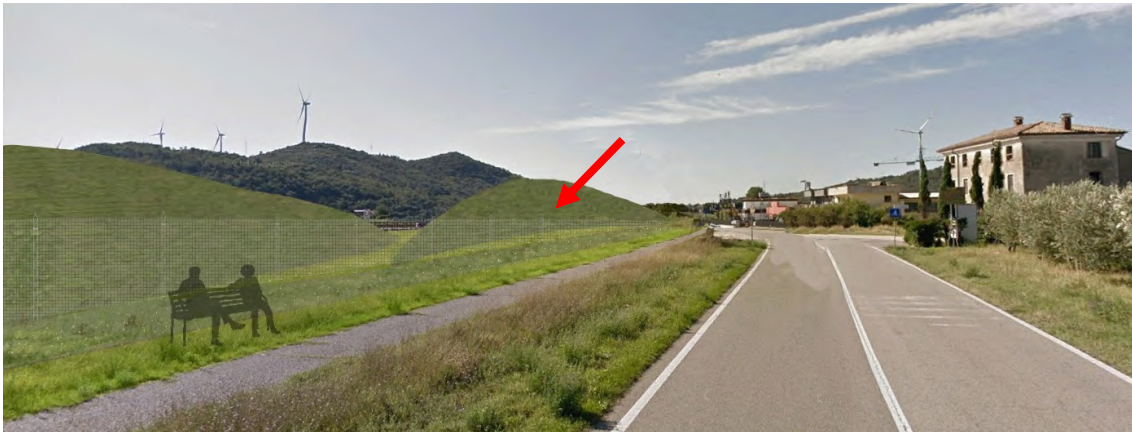
Vista 3: Vista dell'area oggetto di risistemazione morfologica in loc. Vanzelle (vista Streetview © Google 2019) pre e post intervento
