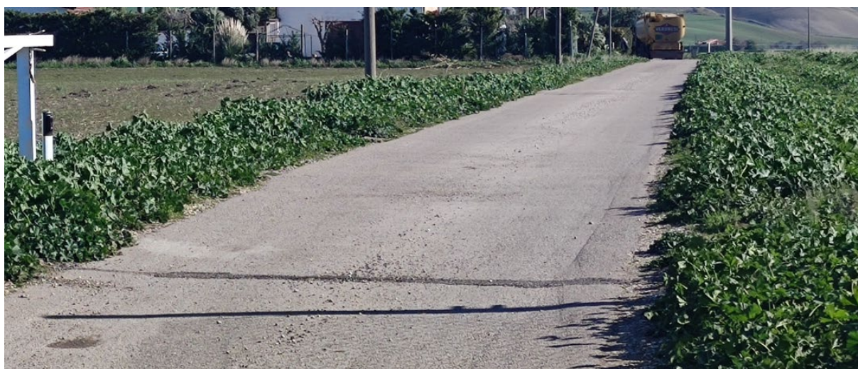
Viabilità in conglomerato bituminoso esistente
