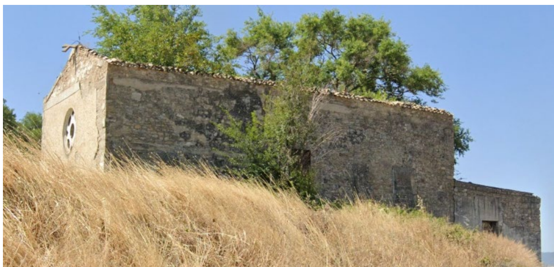
Masseria Sant'Antonio (sito in abbandono)
