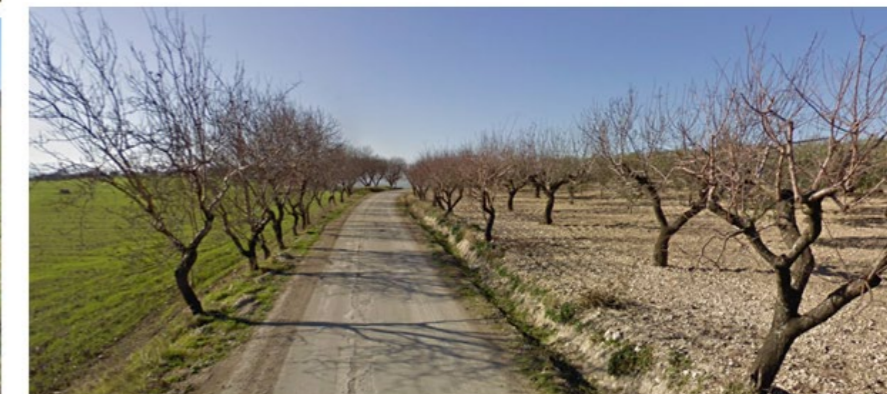
Regio Tratturello Foggia Troia Incoronata (attualmente Strada Esterna Incoronata)
