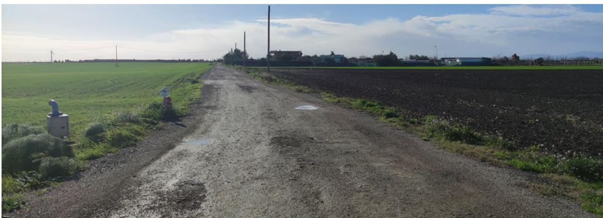
*Viabilità in conglomerato bituminoso esistente in pessimo stato*
