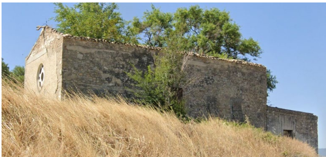
Masseria Sant'Antonio (sito in abbandono)
