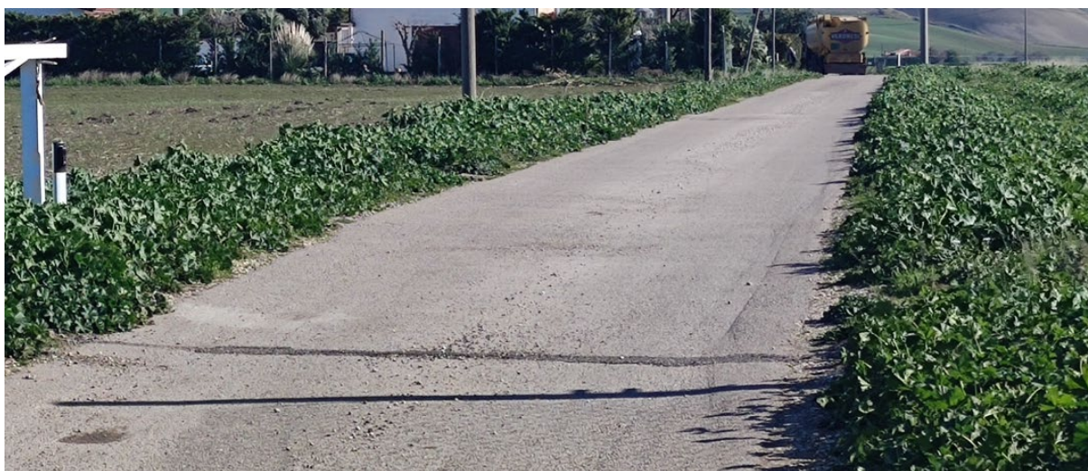
Viabilità in conglomerato bituminoso esistente
