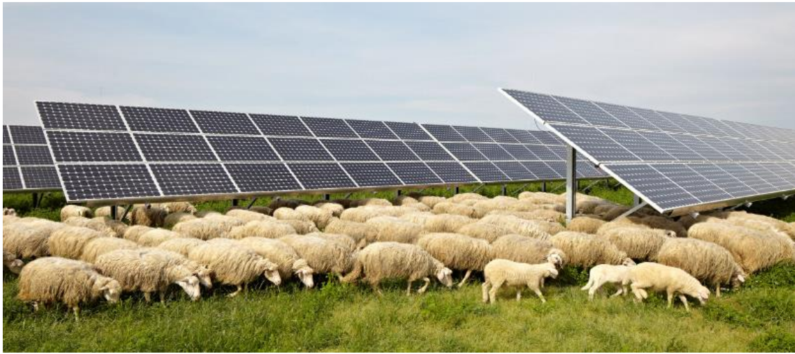
Fig. 5 – Esempio di agrivoltaico
