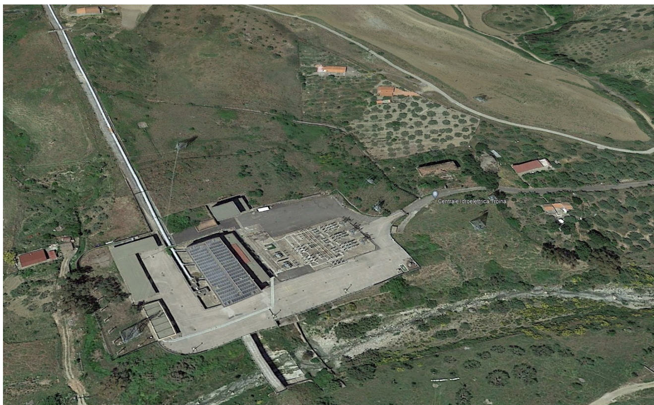
Figura 2-1 – Centrale idroelettrica dell’Enel in c.da Radicone
