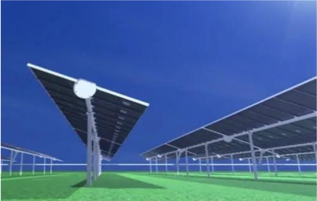
Figura 9-7 – Ombreggiamento dell’interfila dell’impianto mobile monoassiale
