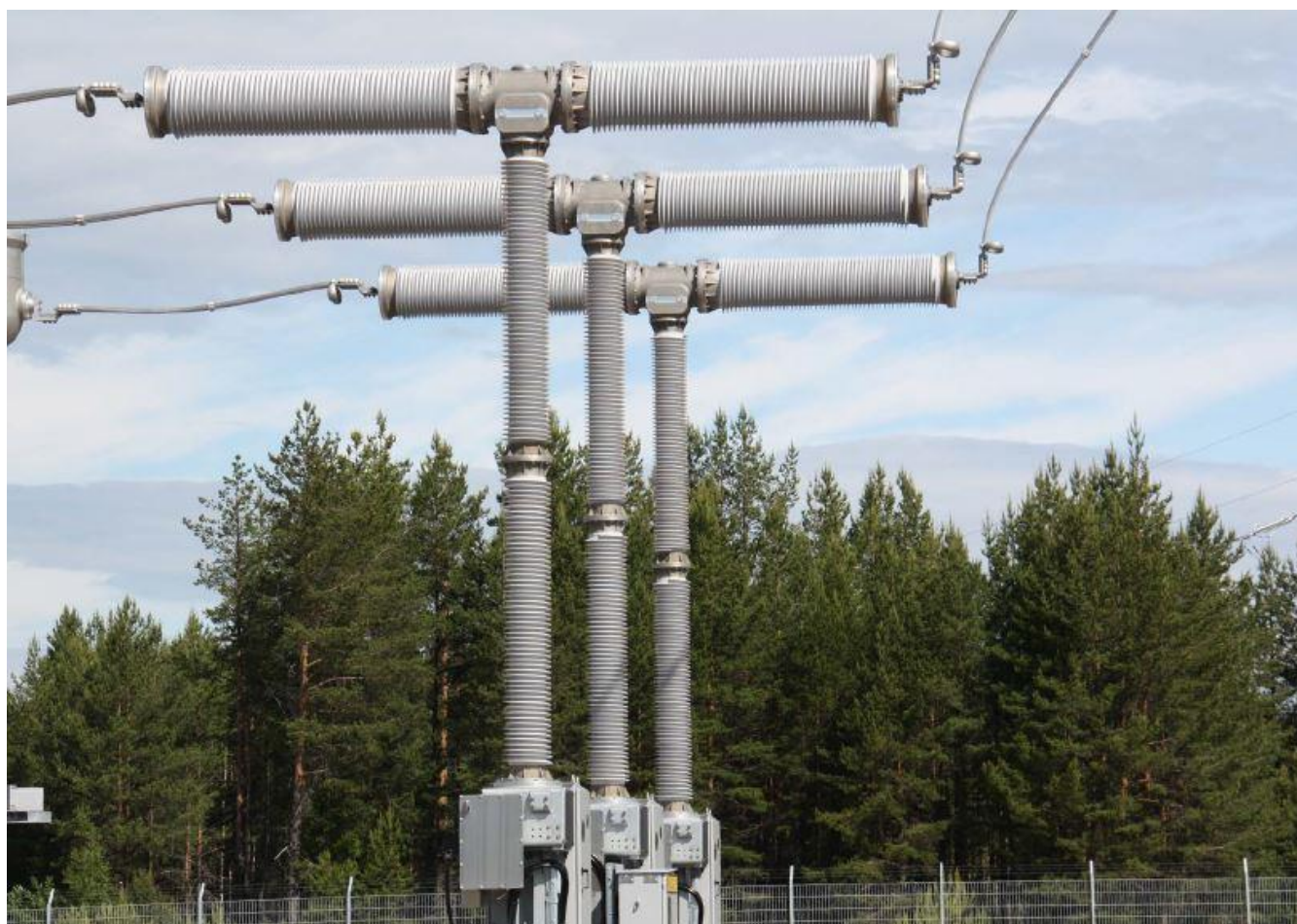
Figura 30 - interruttore 420kV (fonte Siemens)
