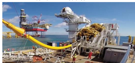
Figura 22 - Particolare dell'imbarcazione posa cavi - NKT Cables
