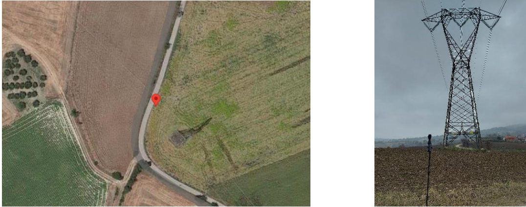
Figura 5 - Punto di misura test elettrodotto 380 kV
