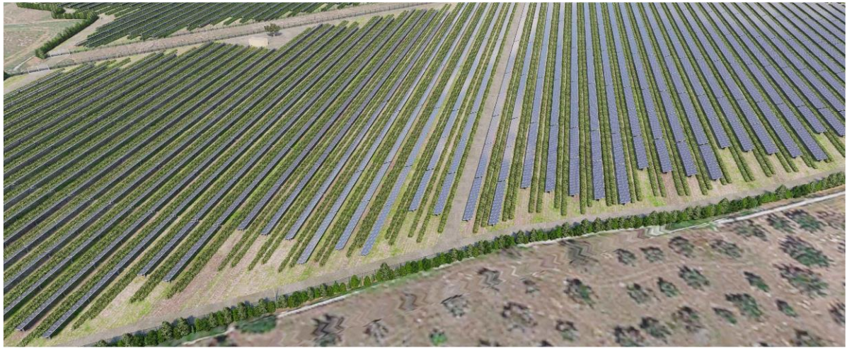
Figura 2: Porzione area impianto post operam
