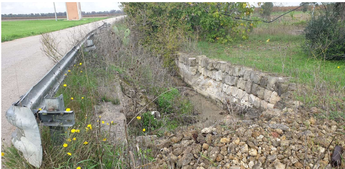
Foto 1 – Attraversamento reticolo idrografico in corrispondenza del punto 1 da fig. 17.
