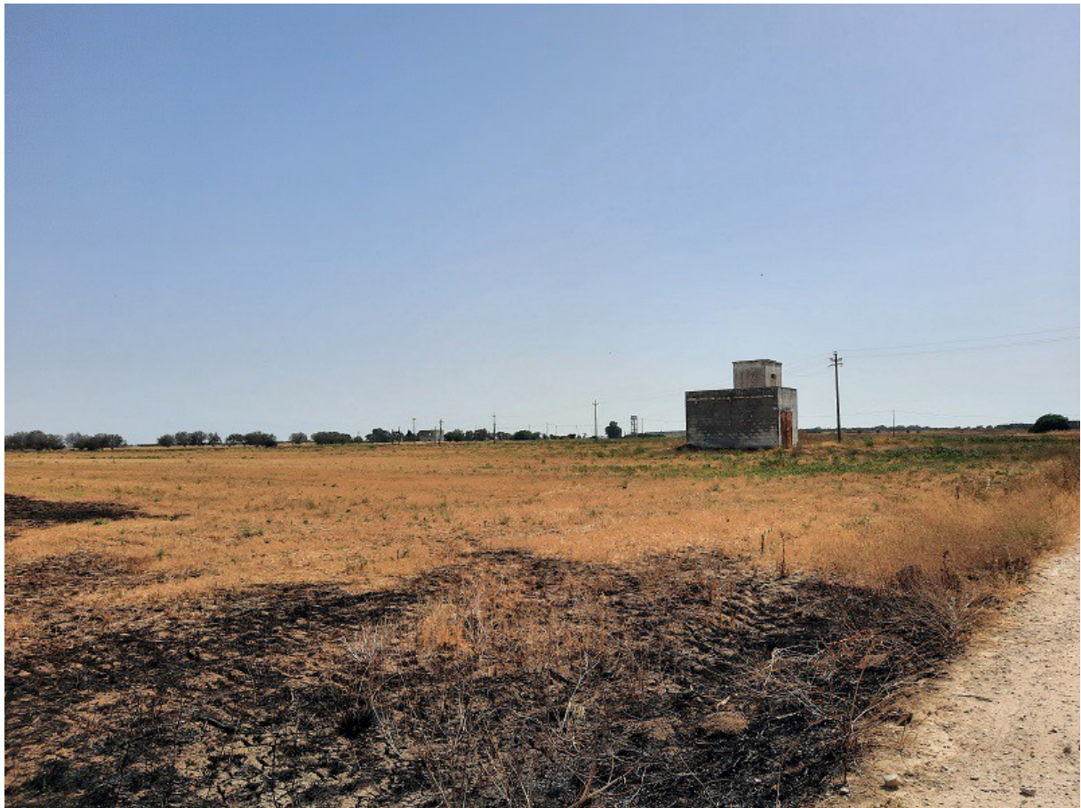
REPORT FOTOGRAFICO AREA – BRINDISI LOIZZO – SCS12 SRL
