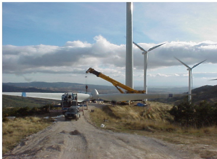
Figura 3-2: Ingombro del rotore a terra
