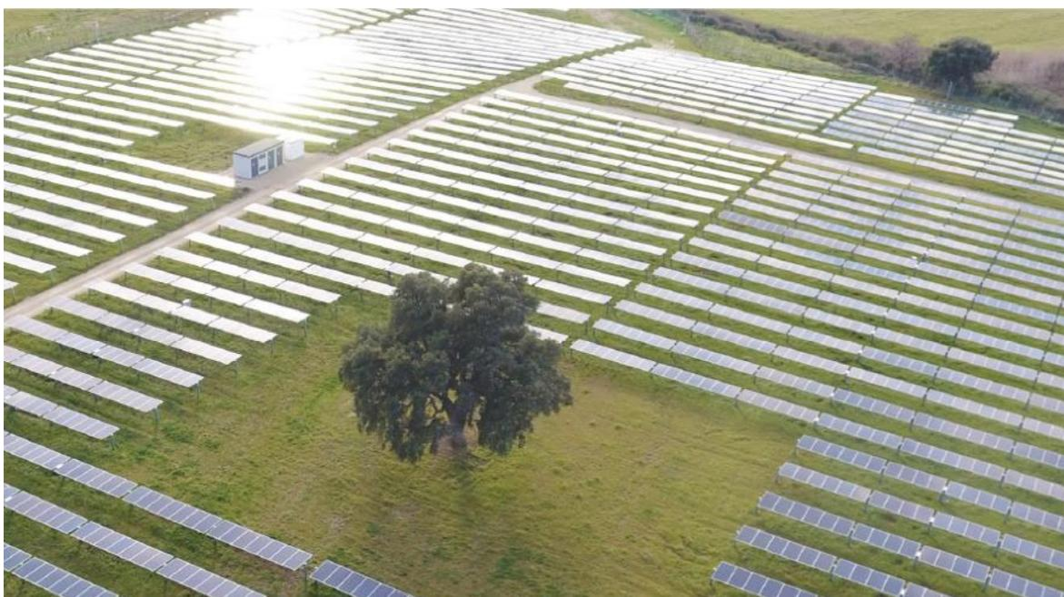
Figura 3 - esempio di impianto realizzato con i tracker proposti e pannelli in configurazione monofilare
