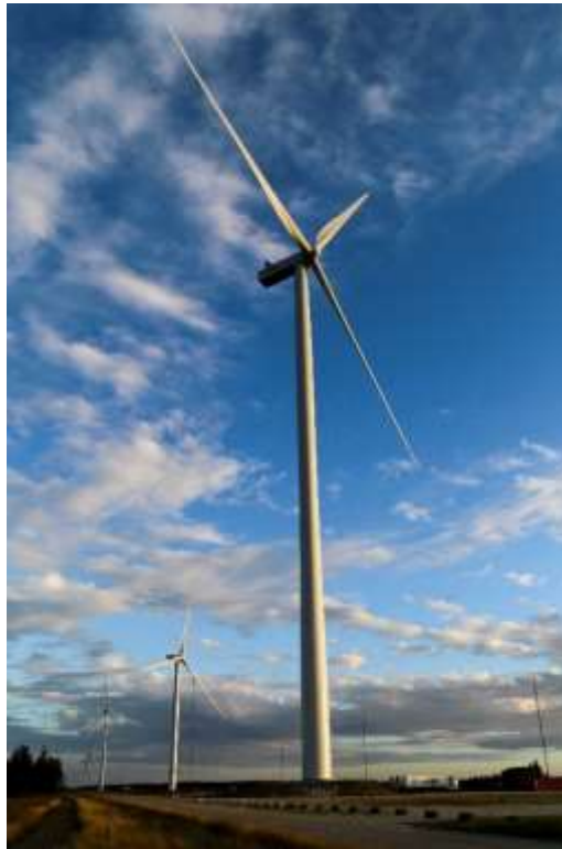
Figura 2 – Aerogeneratore Vestas V150
