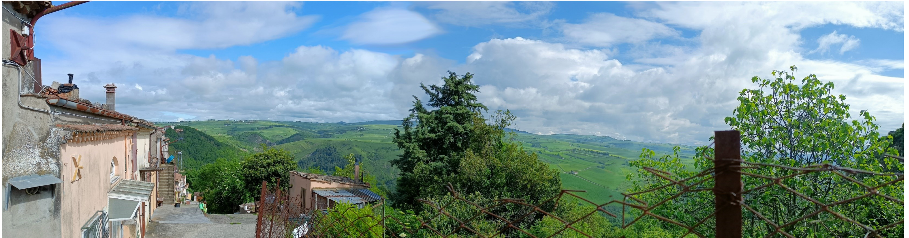
P.to panoramico-belvedere centro storico di Calitri nei pressi della TORRE DELLA PORTA DI NANNO e del CASTELLO DI CALITRI con vista verso Nord/Nord-Ovest
