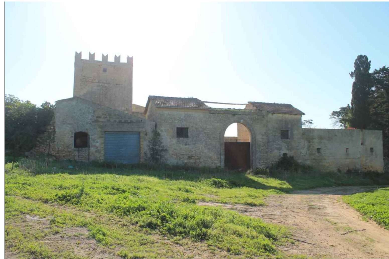
TORRE GRIMESI - bene isolato (311, 312, 313 - ambito 3)
