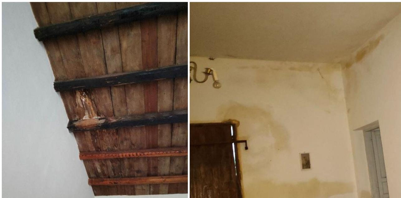
Figura 49 - Infiltrazioni delle coperture (a falde a sinistra, piane a destra)
