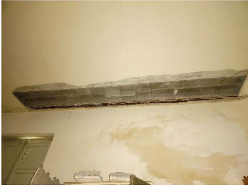
Figura 51 - Fenomeno di sfondellamento solaio in c.a.
