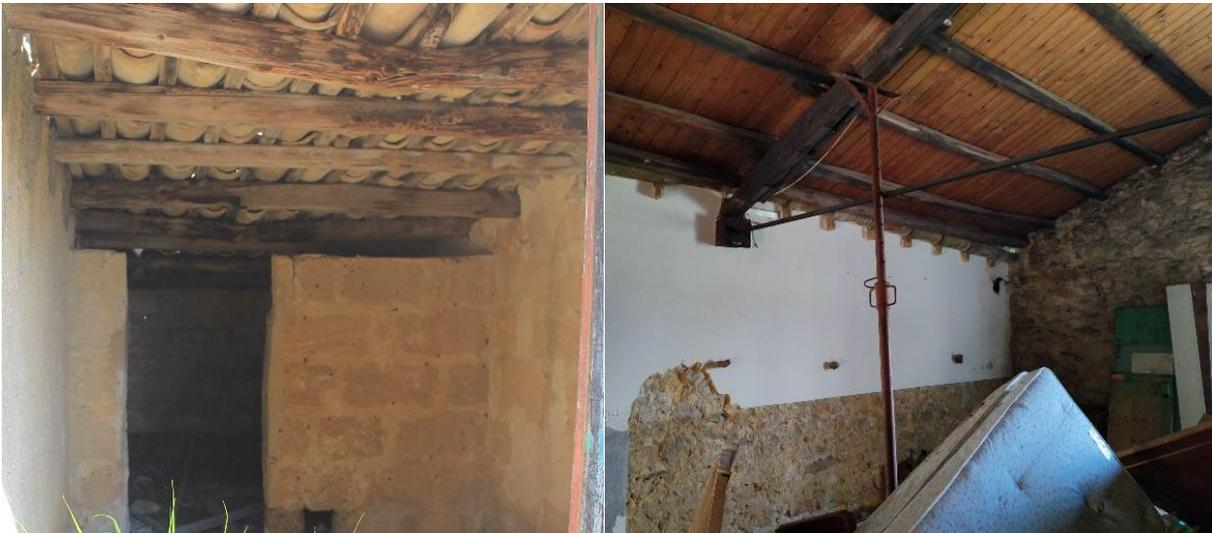
Figura 52 - Cedimento trave lignea copertura deposito a sinistra, cedimento appoggio capriata a destra
