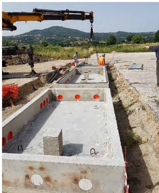
Figura 83 Esempio di basamento delle cabine
