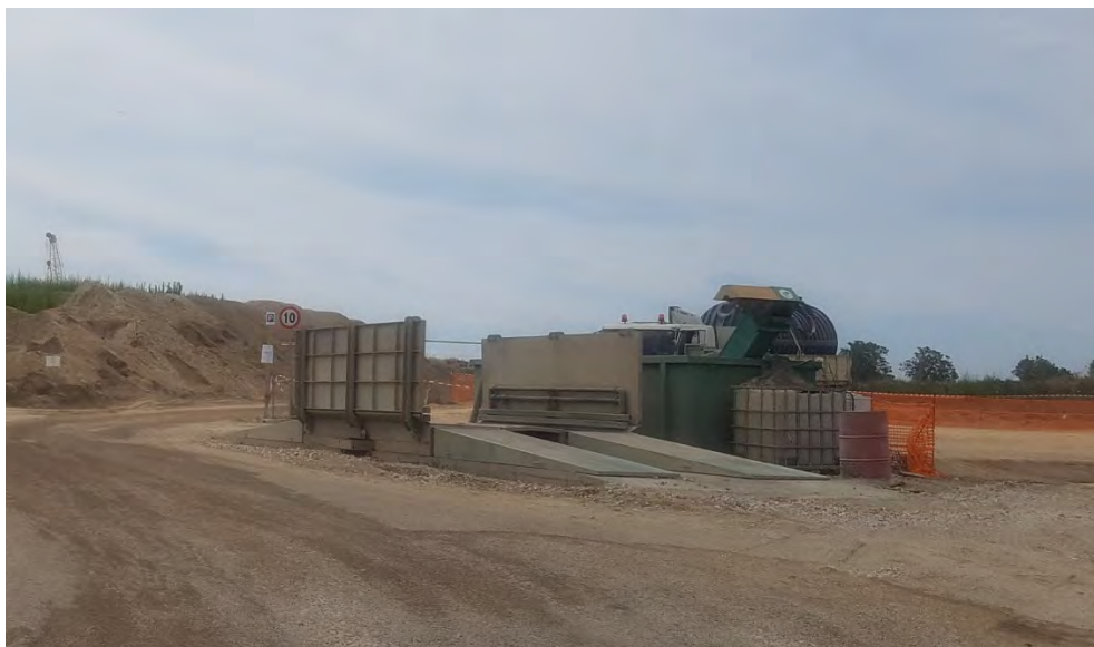
Figura 65 Esempio di impianto automatico lavaggio ruote mezzi d'opera
