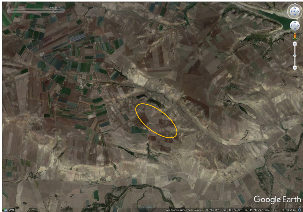
Figura 95 Vista aerea del sito che ospiterà l'impianto e del suo intorno – immagine acquisita in data 21/10/2017 (Fonte Google Earth pro)
