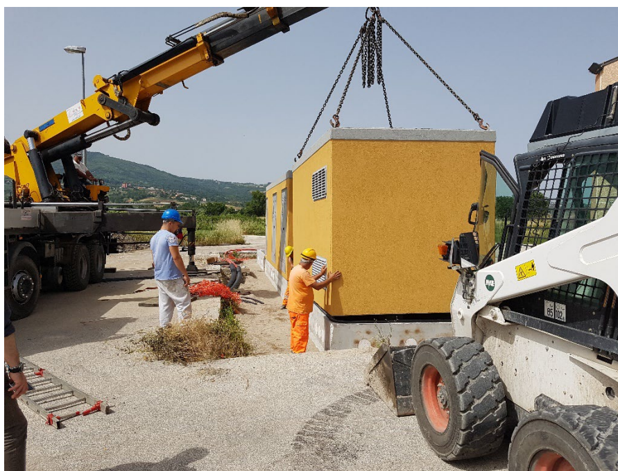
Figura 67 Esempio di posizionamento delle cabine
