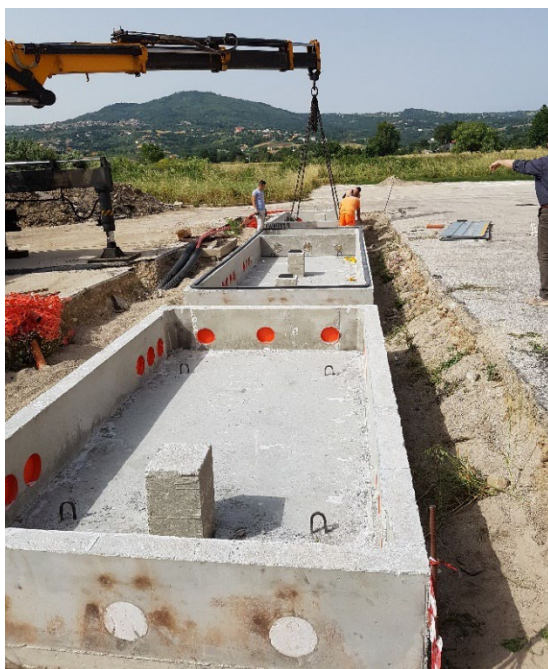
Figura 66 Esempio di basamento delle cabine
