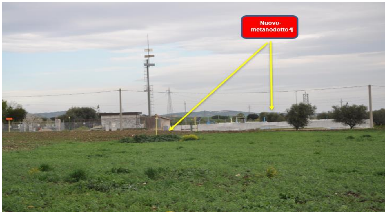
Figura 18 – Sito PR 150 kV Larino – realizzazione opere per nuovo metanodotto
