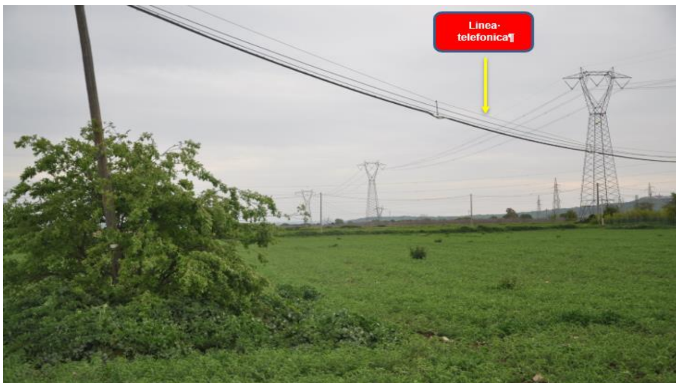
Figura 21 – Sito PR 150 kV Larino – linea telefonica
