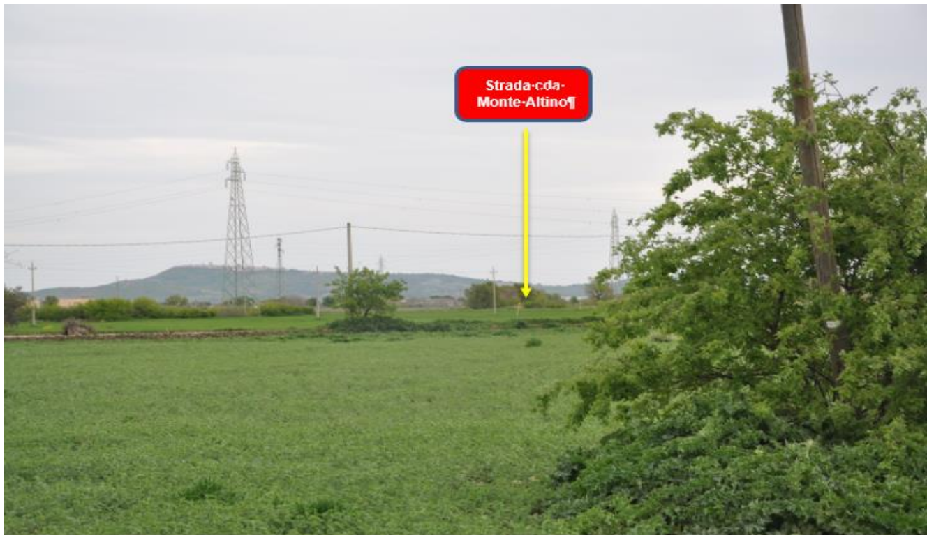
Figura 20 – Sito PR 150 kV Larino
