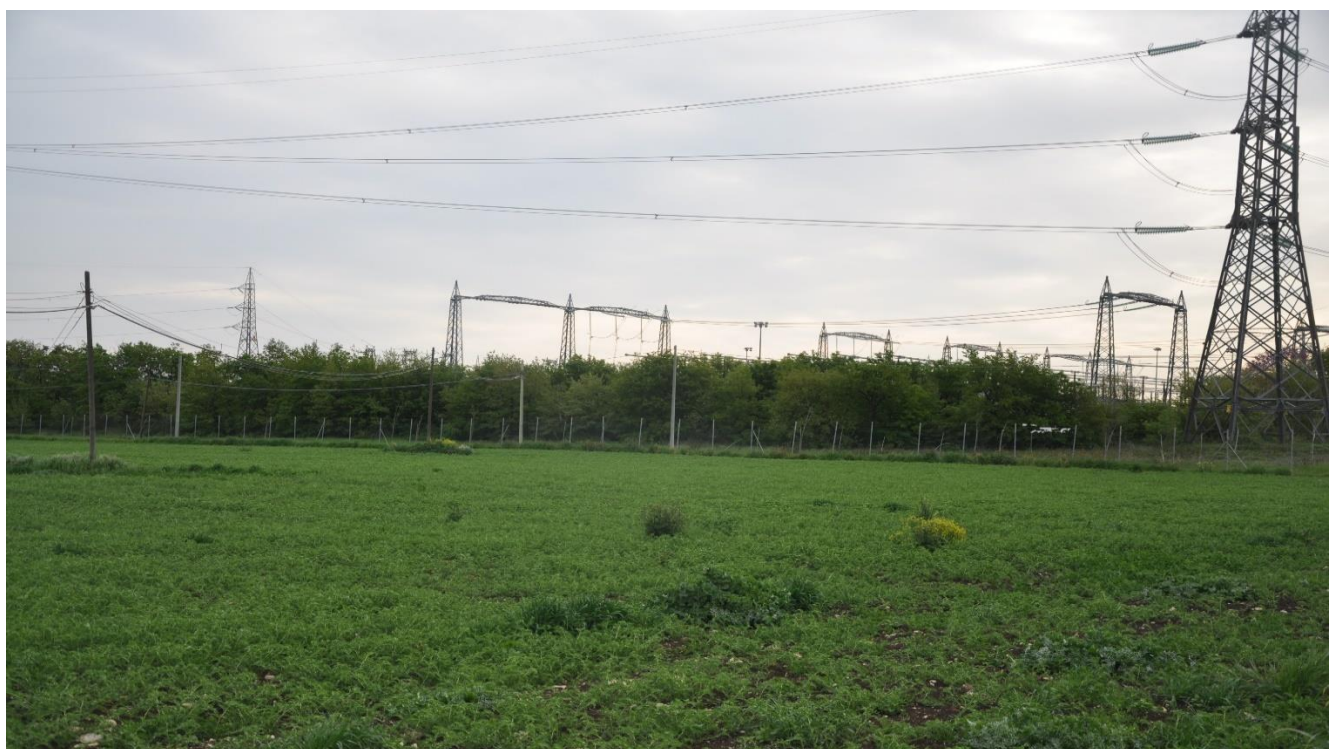
Figura 23 – Sito PR 150 kV Larino in prossimità della Centrale Elettrica di Enel
