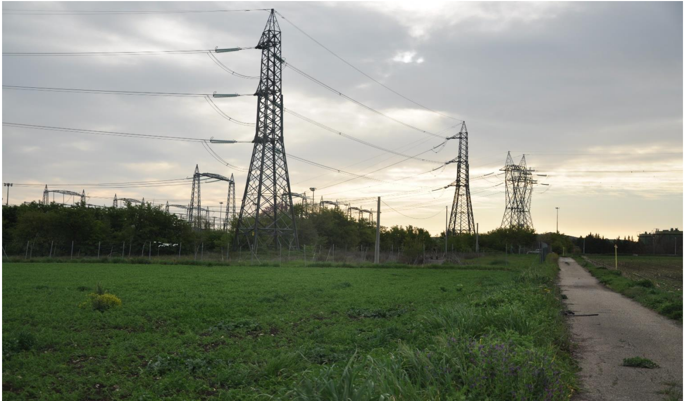
Figura 24 – Sito PR 150 kV Larino in prossimità della Centrale Elettrica di Enel
