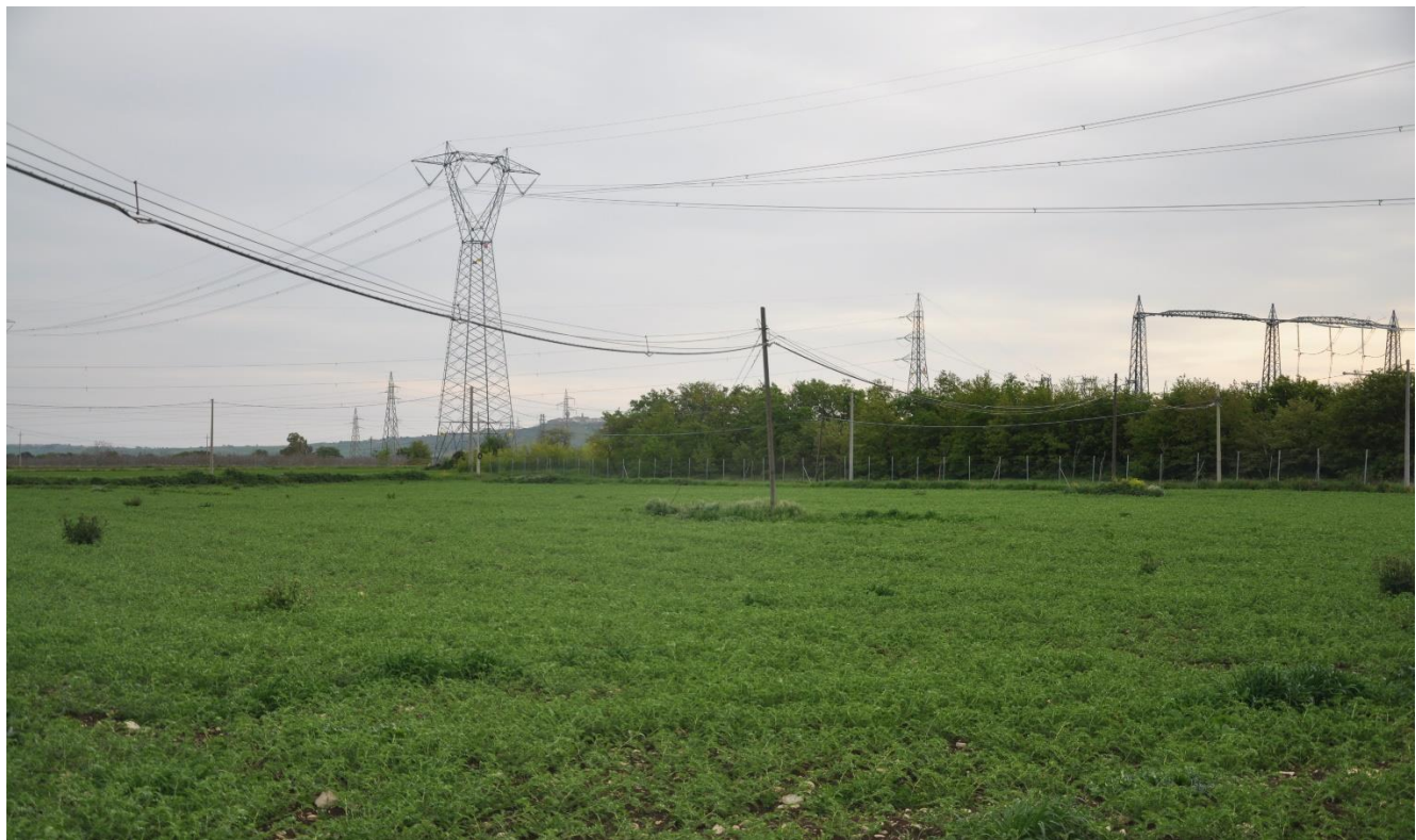
Figura 22 – Sito PR 150 kV Larino in prossimità della Centrale Elettrica di Enel
