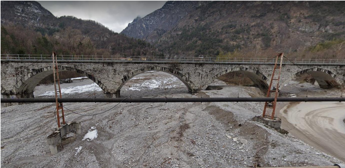
Figura 4 – Vista del torrente Desedan a monte del ponte stradale. Si osservino sulla destra il rilevato intermedio, corrente nella seconda campata del ponte ferroviario, e la strada di accesso alla cava di valle.
