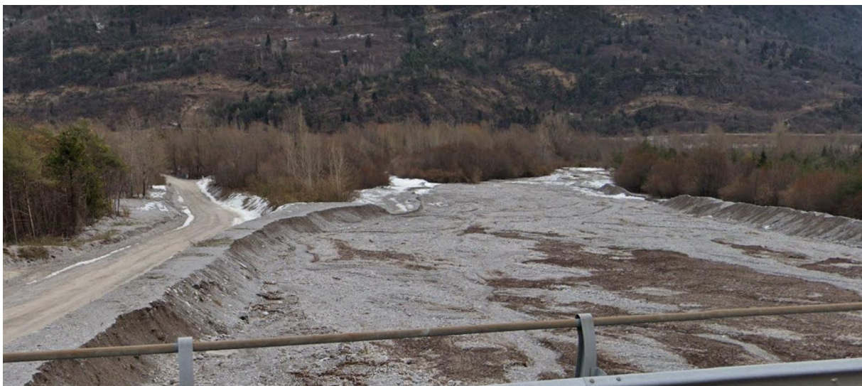
Figura 5 – Vista del torrente Desedan a valle del ponte stradale. La strada di accesso alla cava, a sinistra, ha giacitura inferiore al letto dell'alveo.
