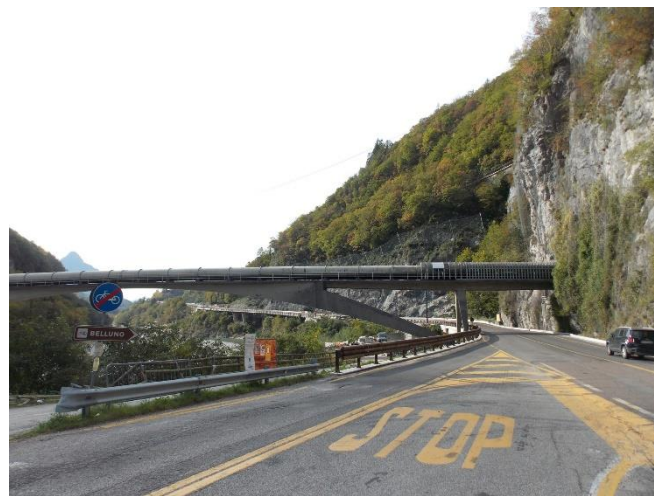
Figure 63: Il bivio presso il punto di riallacciamento della strada in progetto con la S.S. 51 (km 10+900), verso sud
