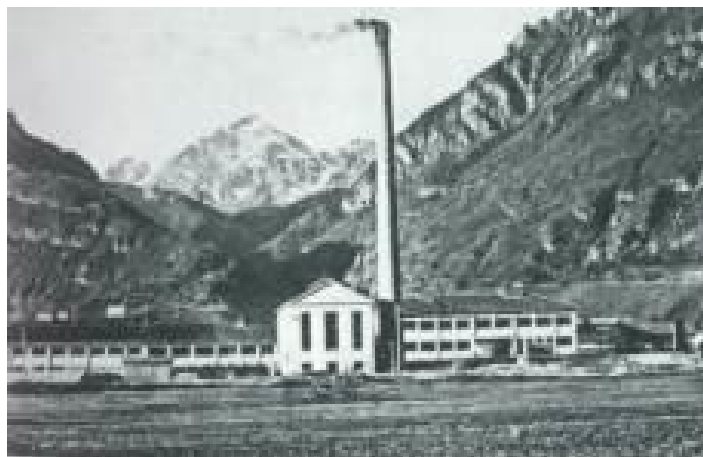
Figure 21: Lo stabilimento della Faesite in loc. Faè.
