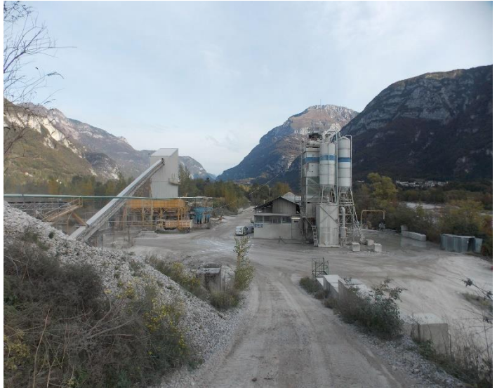
Figure 40: L'area dello stabilimento che sarà attraversata dalla variante in progetto (km 4+100), verso nord
