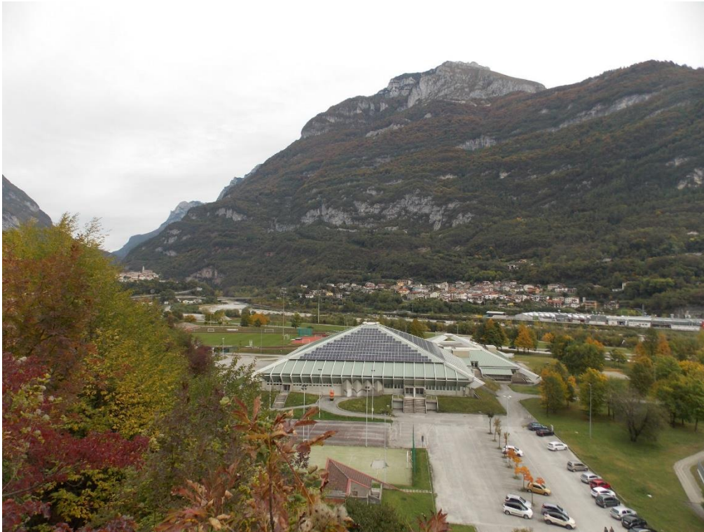
Figure 55: Il Palasport (km 8+200) visto dalla S.S. 51, con la frazione di Codissago al di là del Piave sul fondo
