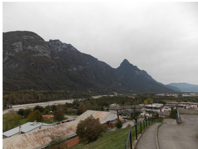
Figure 47: Longarone, con la zona industriale di Villanova visibile a destra, verso sud La strada in progetto è prevista sulla sinistra a ridosso del Piave
