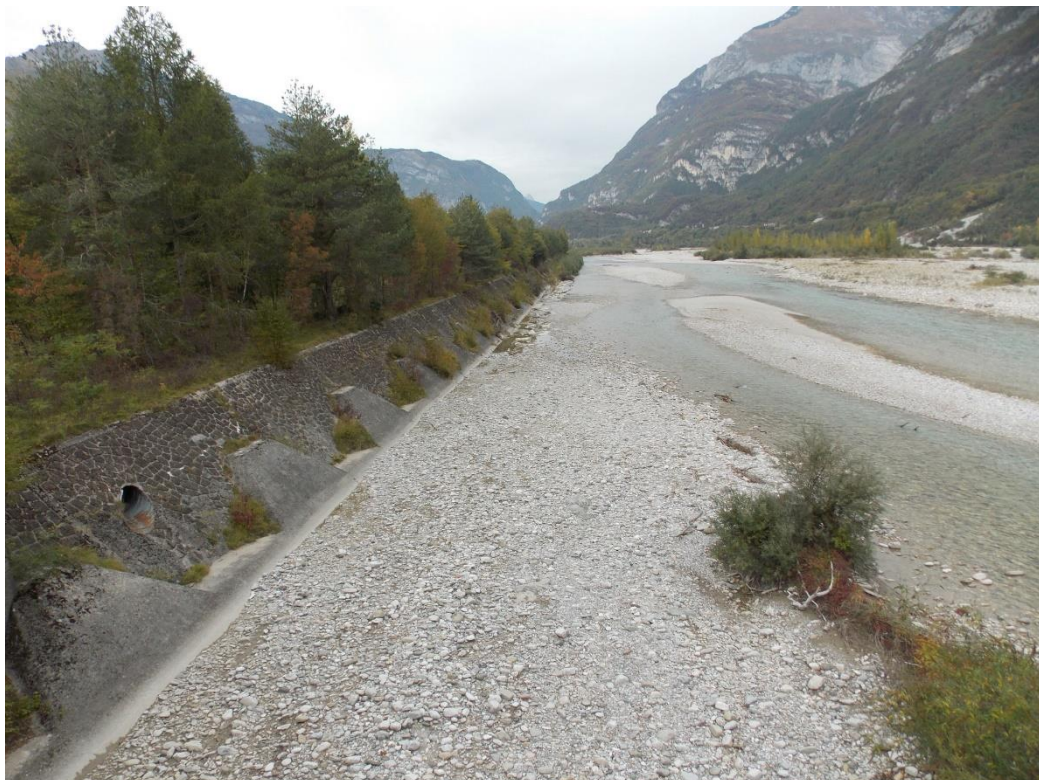
Figure 45: L'argine sulla sponda occidentale del fiume (km 5+050), la strada in progetto attraverserà il bosco sulla sinistra
