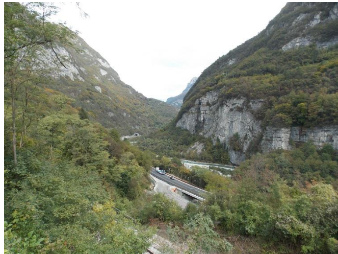
Figure 62: Il fondovalle sotto Torre della Gardona, sullo sfondo l'imbocco della galleria di Termini, verso nord
