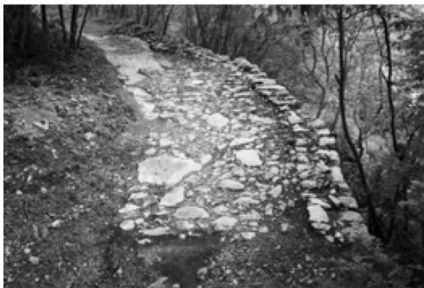
Figure 11: Strada lastricata presso la chiusa della Gardona (da Rossignoli, Rossi 2018)
