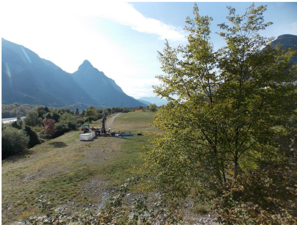
Figure 51: Realizzazione di controlli geognostici sul tracciato in progetto a sud del ponte Campelli (km 7+700)
