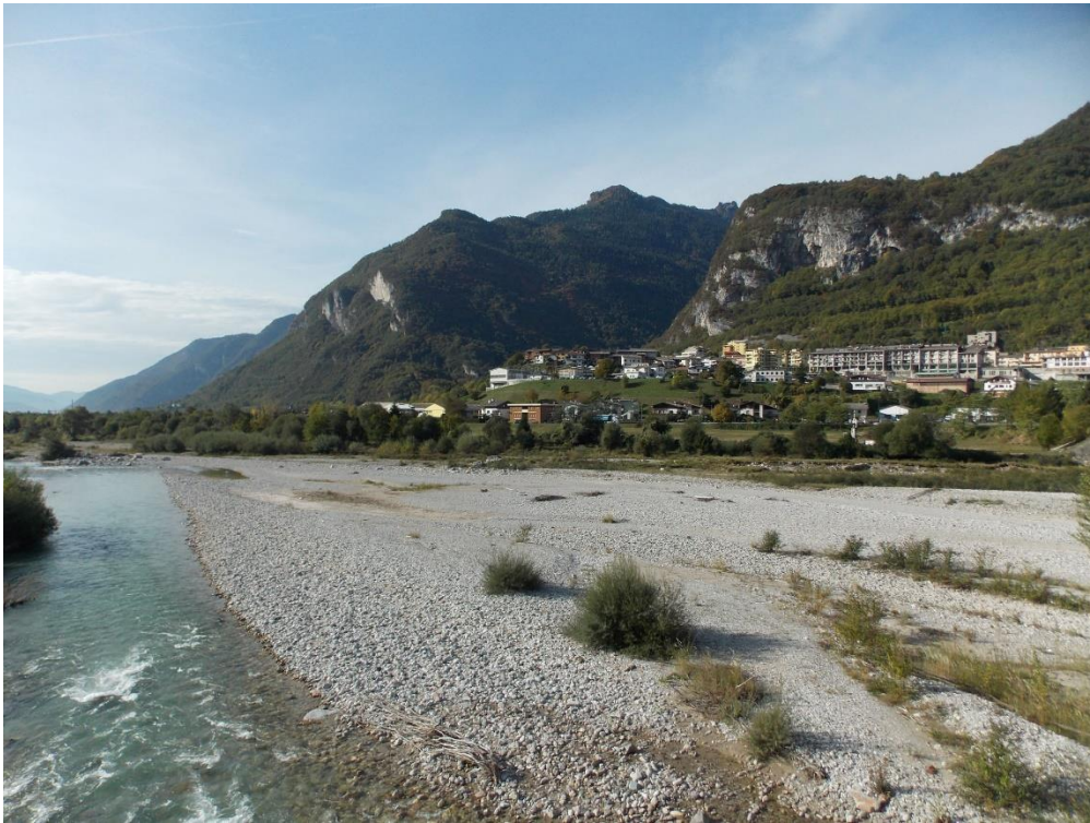
Figure 49: La porzione meridionale del centro di Longarone vista dal ponte Campelli (km 7+740), verso sud.
