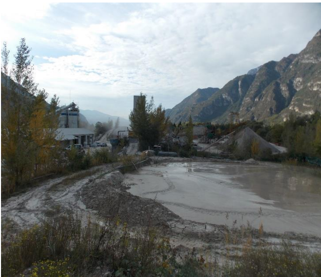
Figure 41: Lo stabilimento industriale a nord del torrente Desedan (km 4+100), verso sud.
