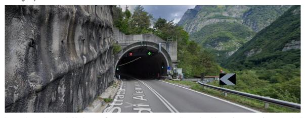
In corrispondenza dell'imbocco è presente una curva di raggio ridotto (ca. 150m); essendo in presenza di strutture esistenti al di fuori dell'ambito dell'intervento, tale elemento geometrico non è modificabile; all'interno della galleria il tracciato si raccorda progressivamente ad una curva di raggio più ampio e infine ad un rettifilo.
