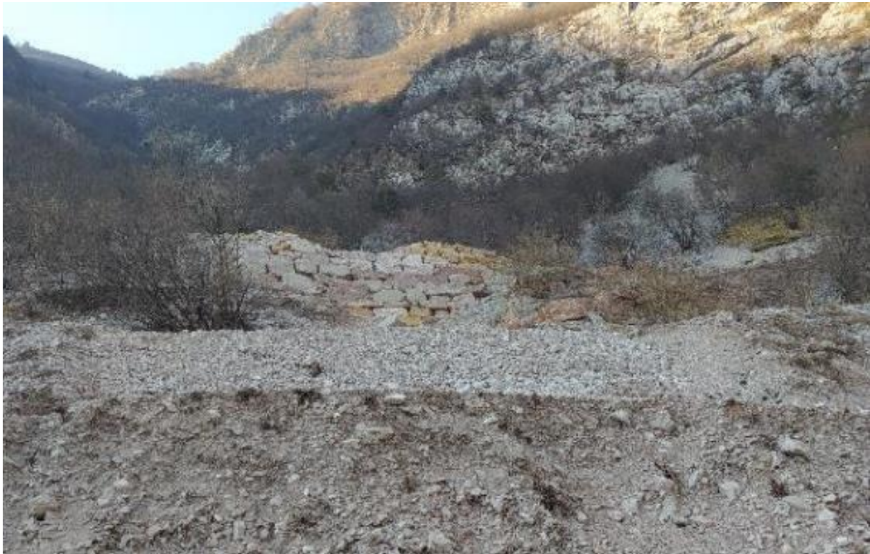
Fig. 23 - Sistemi di ritenuta e controllo del ruscellamento e del trasporto solido nel settore di monte del corpo detritica interessato dai fenomeni di debris flow
