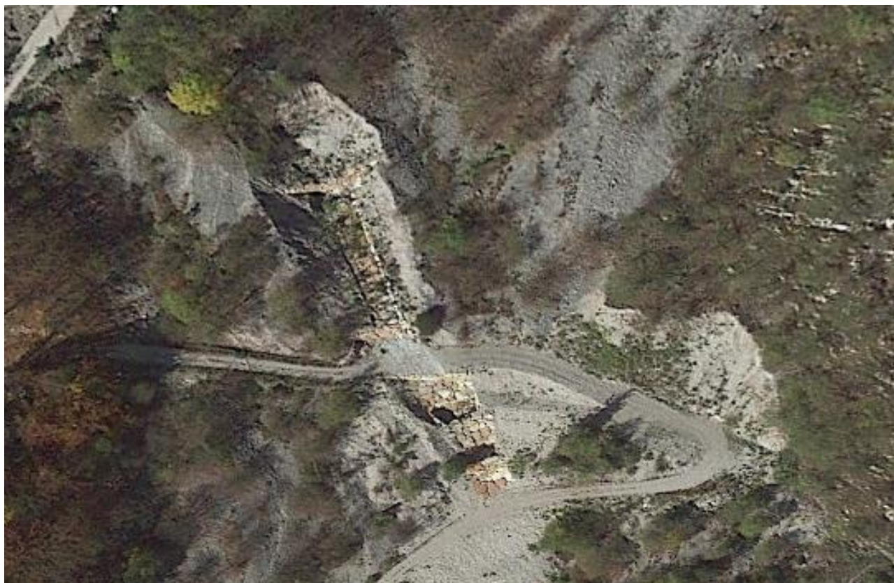
Fig. 22 - Sistemi di ritenuta e controllo del ruscellamento e del trasporto solido nel settore di monte del corpo detritica interessato dai fenomeni di debris flow (foto da Google Earth)
