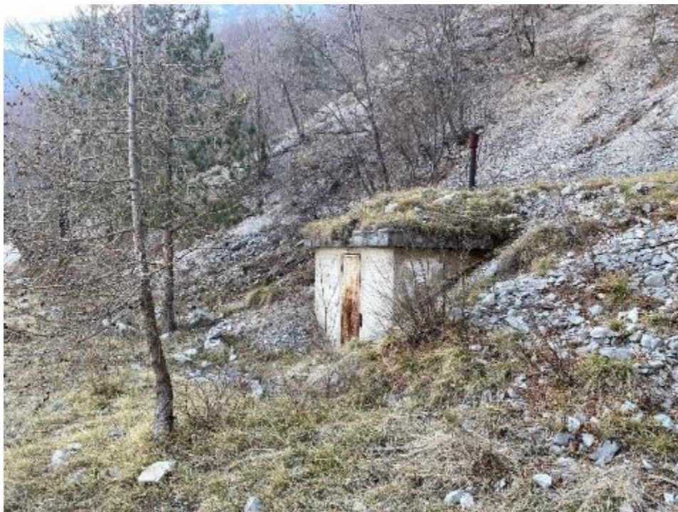
Fig. 70 – Casotto di protezione opera di presa sorgente S4
