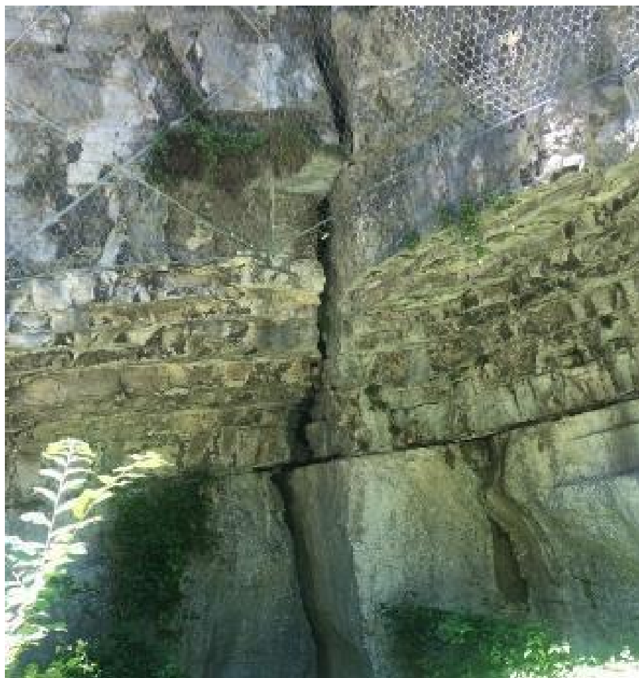
Fig. 37 - Interventi di soil nailing sulla falesia (dissesto IFFI 025012110)
