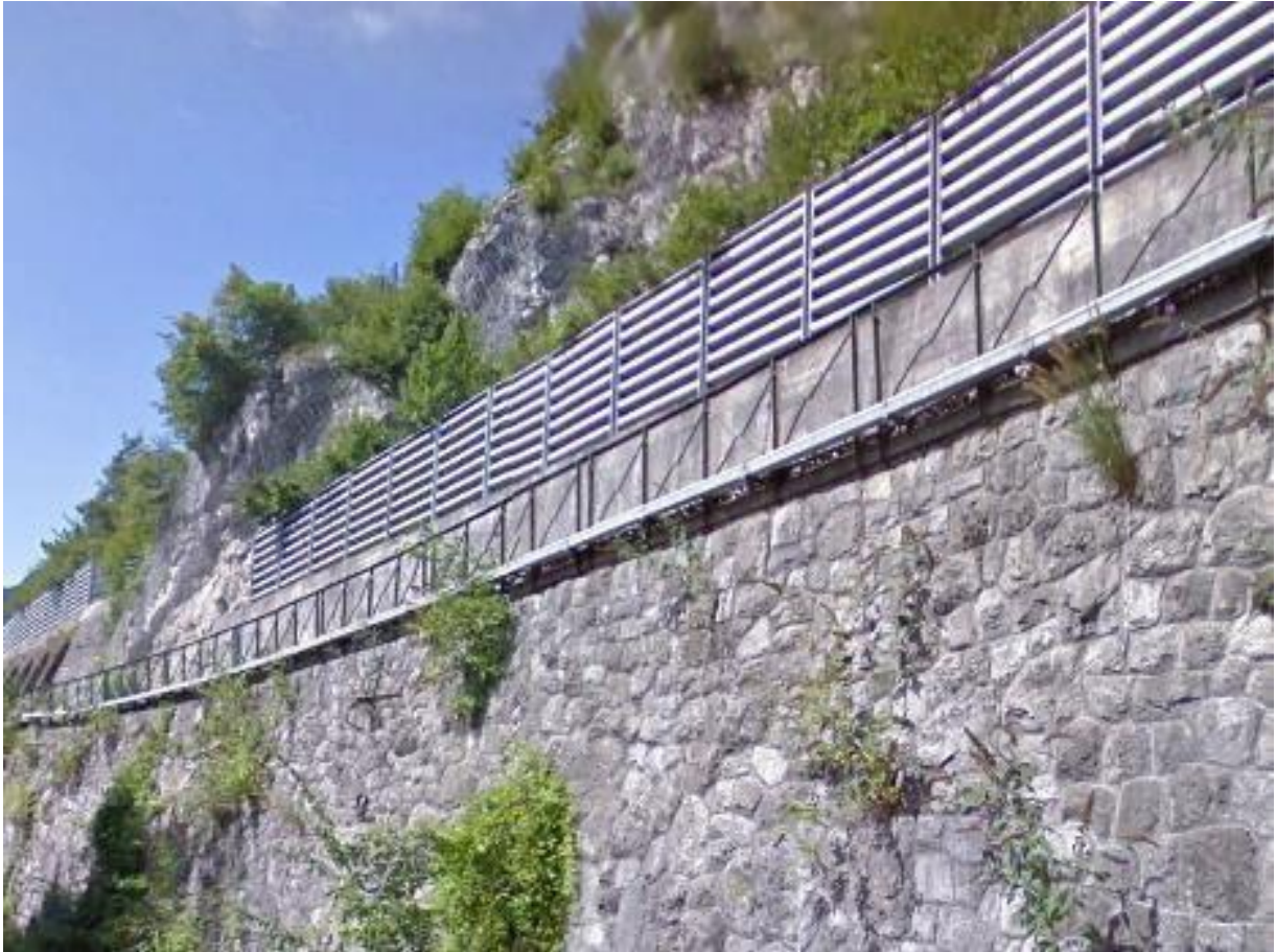
Fig. 49 - Barriera paramassi a protezione del tracciato ferroviario (vista da pista sotto linea FFSS)
