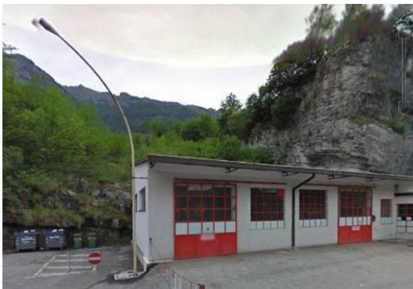
Fig. 35 - Vista dell'area interessata dal dissesto antico (dissesto IFFI 025012100).
