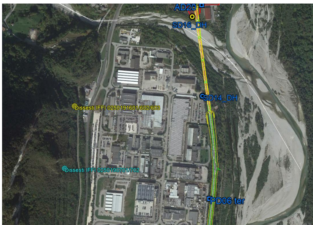
Ubicazione delle frane 02501190601/602/603
