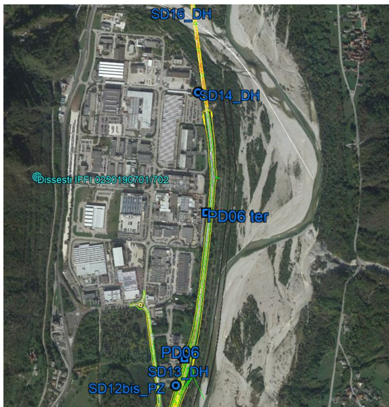
Ubicazione delle frane 02501190701/702
