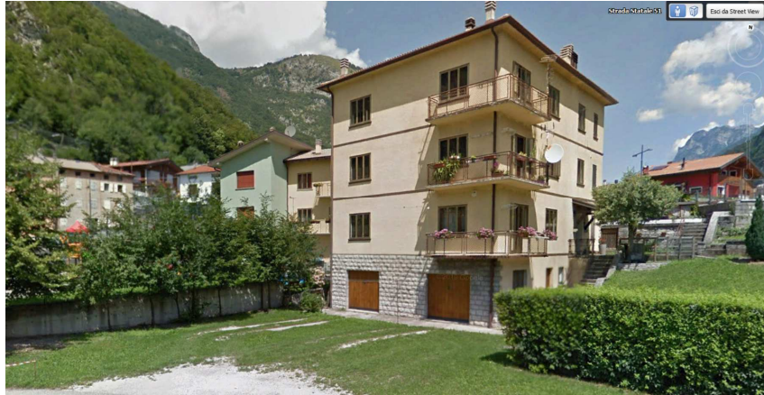
Figura: Foto fabbricato 1 - progressiva 9+480 (vista da sud).
