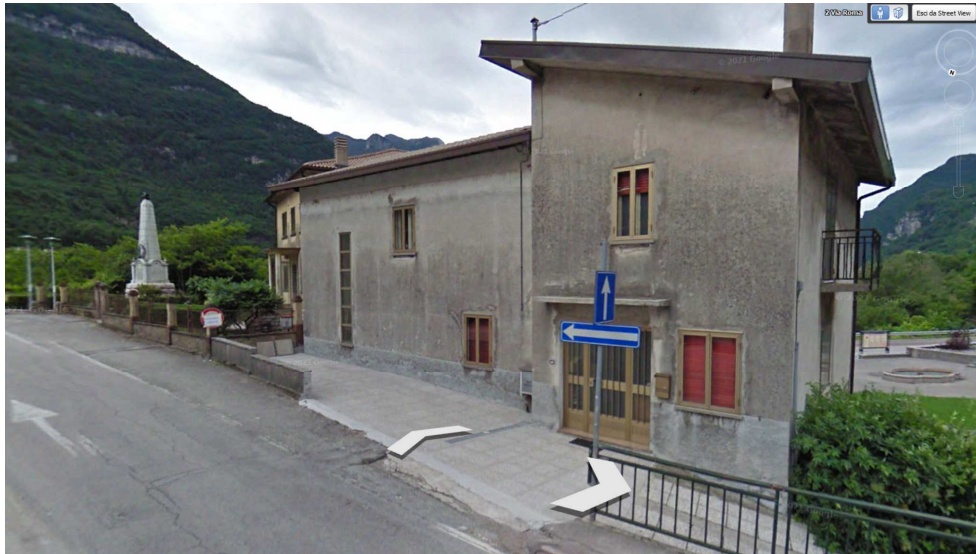
Figura: Foto fabbricato 2 - progressiva 9+480 (vista da nord).
