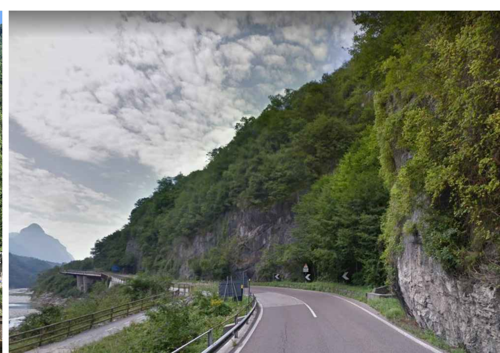
Vista fronte Sud - Imbocco galleria
