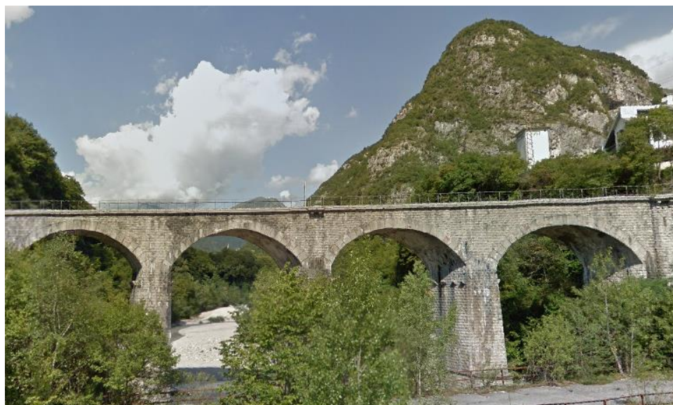
Figura 8-31 Elementi del sistema infrastrutturale: sovrappasso ferroviario in località Muda Maè (Fonte: Google Earth)
