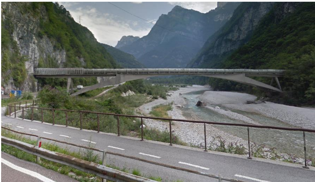
Figura 8-30 Elementi del sistema infrastrutturale: Ponte Canale e tratto ciclabile in località Castellavazzo (Fonte: Google Earth)
