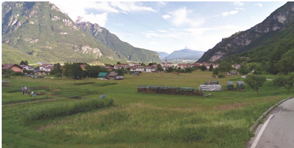
Figura 2-2 Vista dell'area CB01 da Via della Scesura
