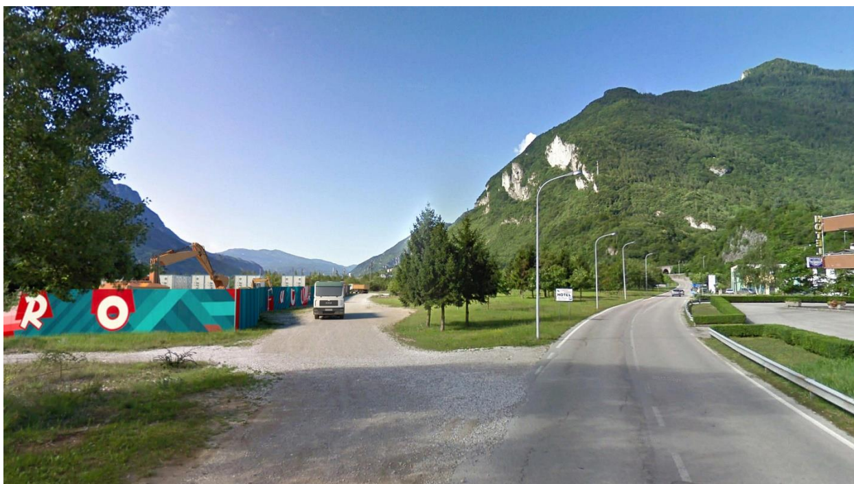
Figura 1-33 Recinzione di cantiere con pannelli comunicativi
