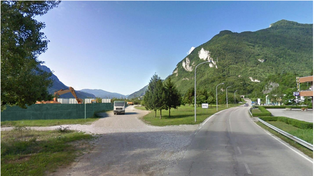
Figura 1-31 Recinzione di cantiere con rete
