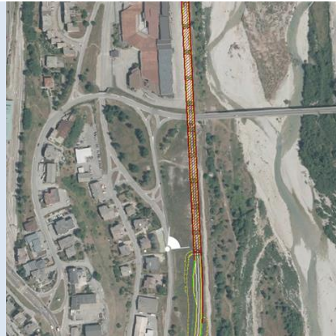
Cono ottico: veduta laterale verso il tratto del Viadotto Fiera (VI_05).
