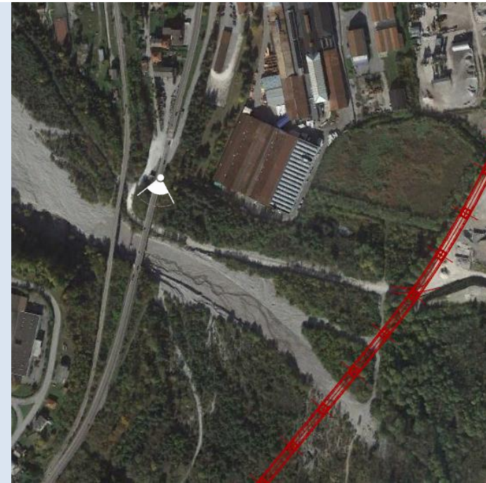
Cono ottico: veduta verso il Viadotto Desedan (VI_02).
