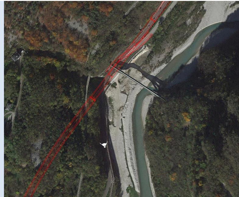
Cono ottico: veduta verso il tratto il viadotto Fason (VI07)
