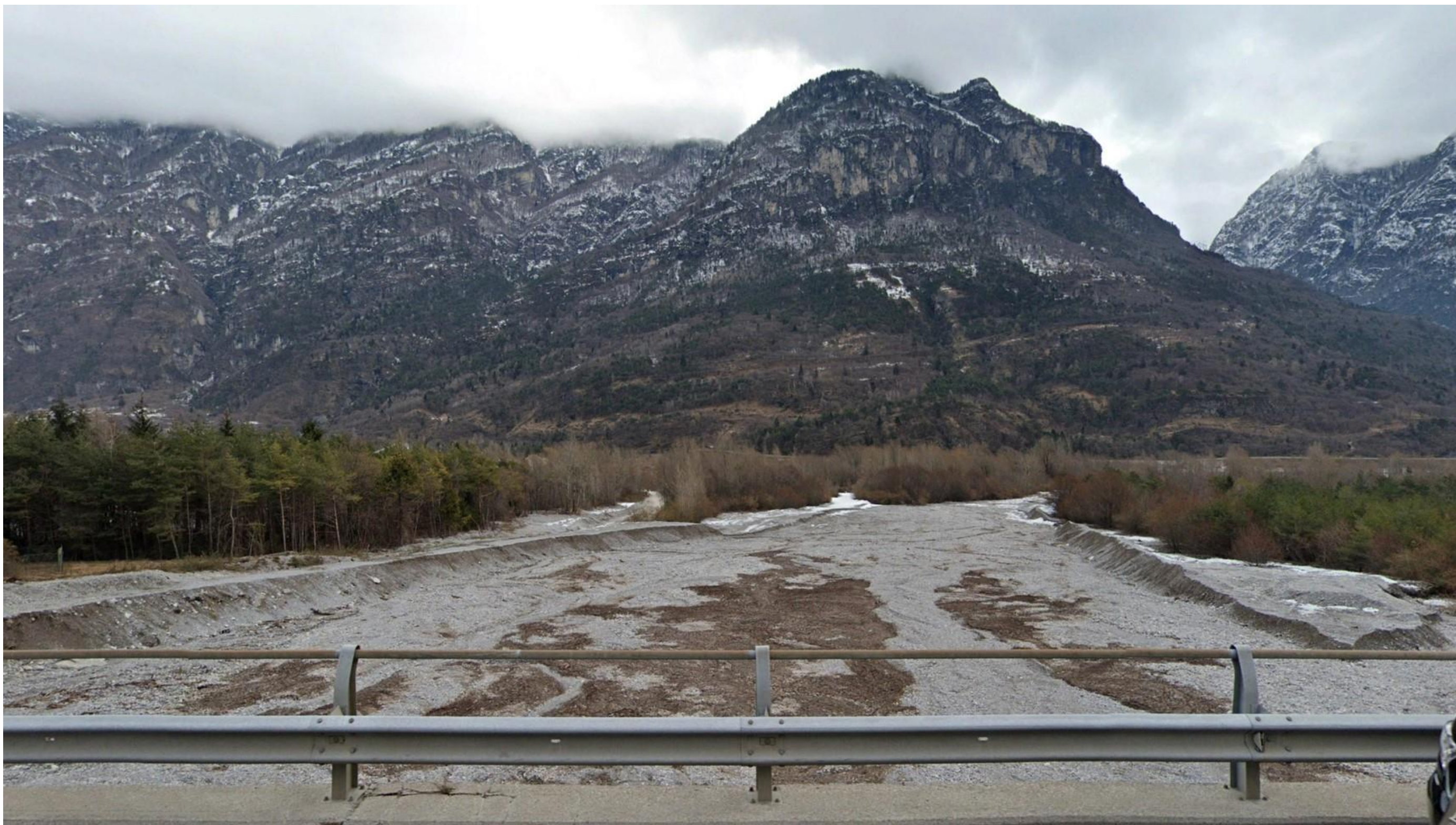
Figura 6: in corrispondenza della pk 4+000 - Vista dall'attuale strada dAlemagna in direzione del Viadotto Desedan, che si sviluppa per circa un chilometro. Dalla vista è possibile osservare il greto del fiume in corrispondenza del punto in cui il Torrente Desedan confluisce nel Fiume Piave e sullo sfondo i rilievi montuosi. (Fonte: Google Earth).
