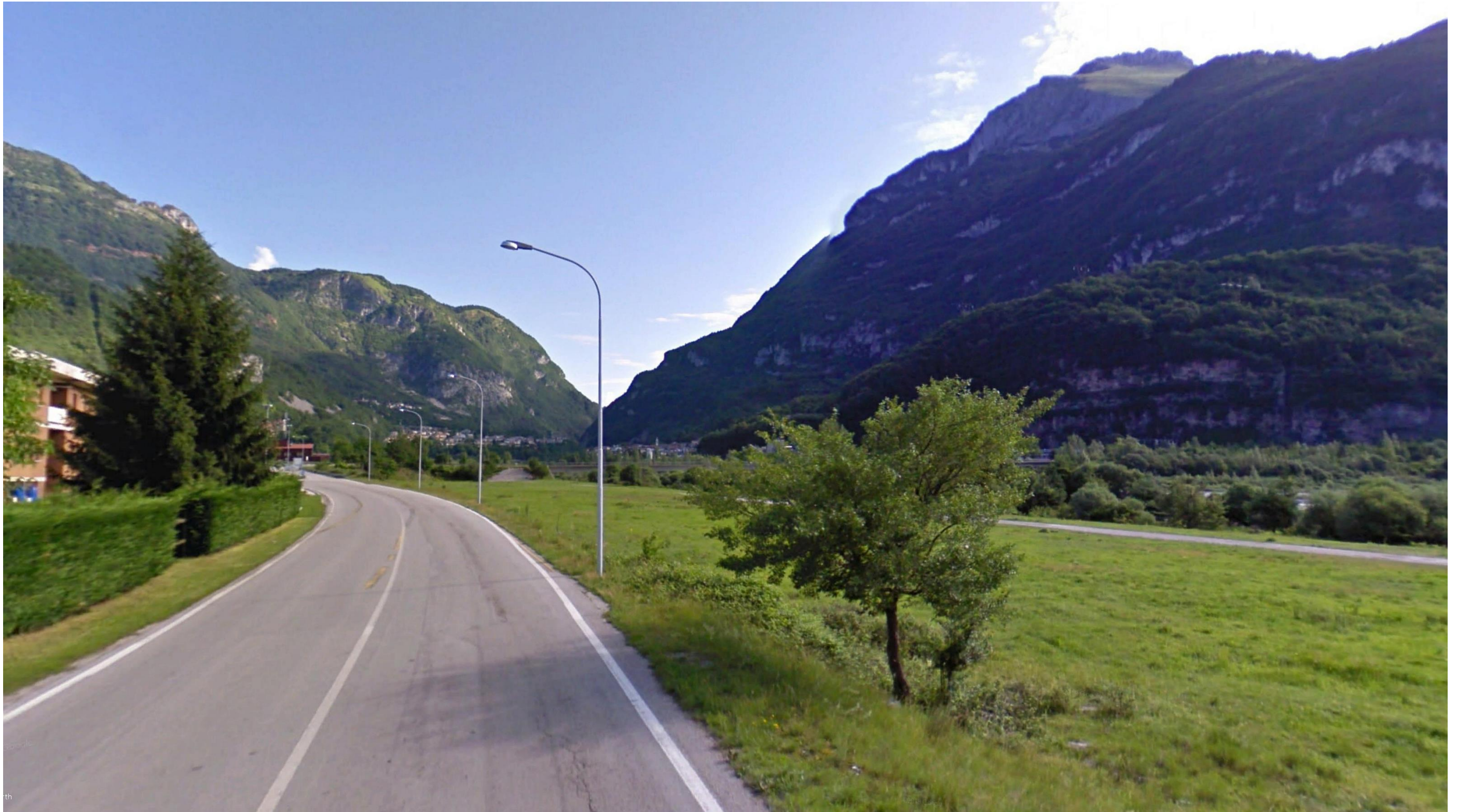
Figura 10: in corrispondenza della pk 7+450 ca.- Vista individuata in corrispondenza della Via Gianfranco Trevisan in direzione N. La visuale è rivolta verso il tratto iniziale del Viadotto Fiera, che si sviluppa per circa 470 metri. Il tratto in viadotto occuperà il terreno erboso posto al margine destro della Via Trevisan (Fonte: Google Earth)
