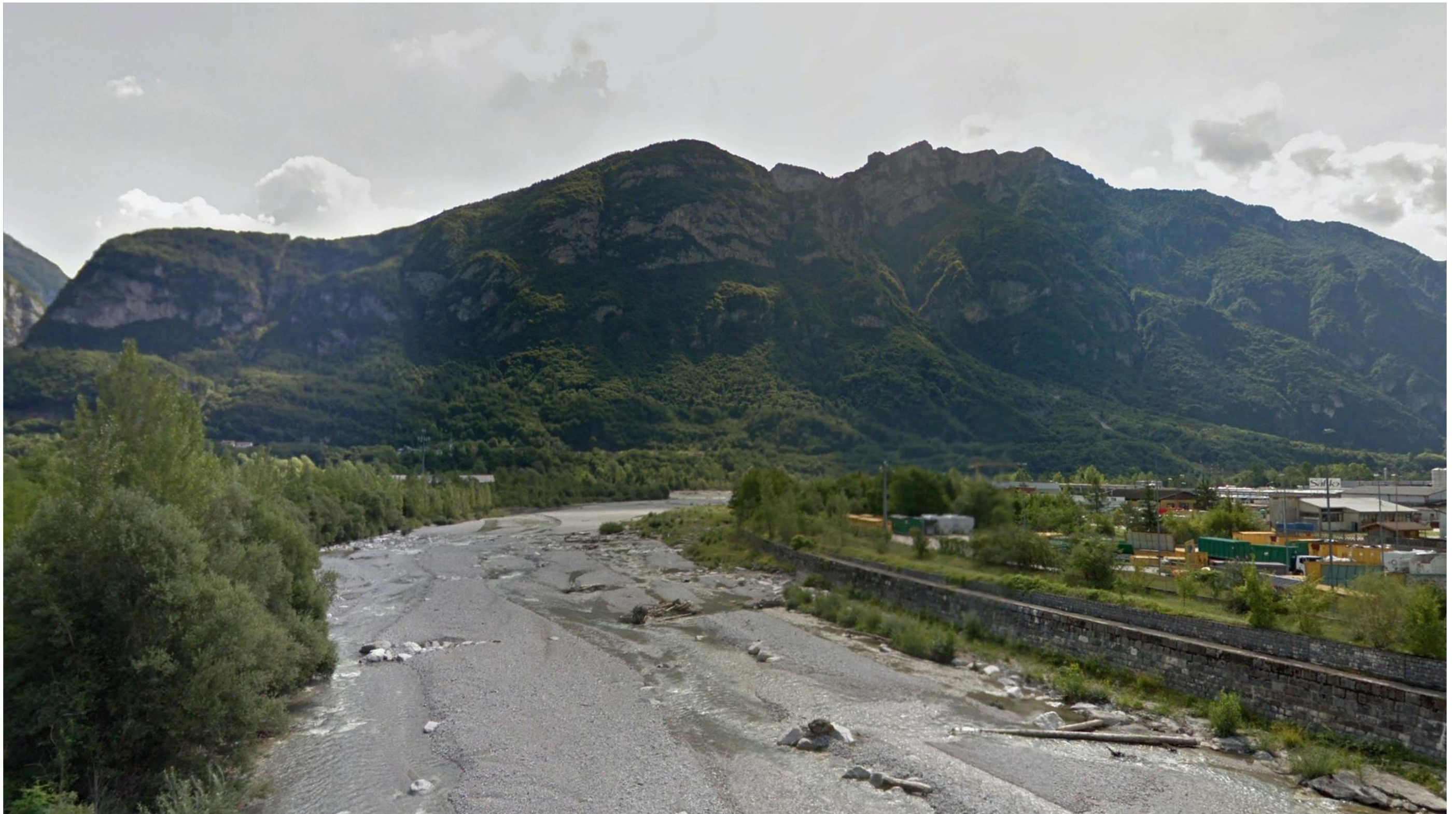
Figura 8: in corrispondenza della pk 6+850. circa – Vista individuata dalla Via Gianfranco Trevisan, parallela all'attuale SS 51. La visuale è rivolta in direzione del Viadotto Maè, che si sviluppa per circa 480 metri. Nella foto a destra è visibile l'insediamento industriale Villanova. (Fonte: Google Earth)
