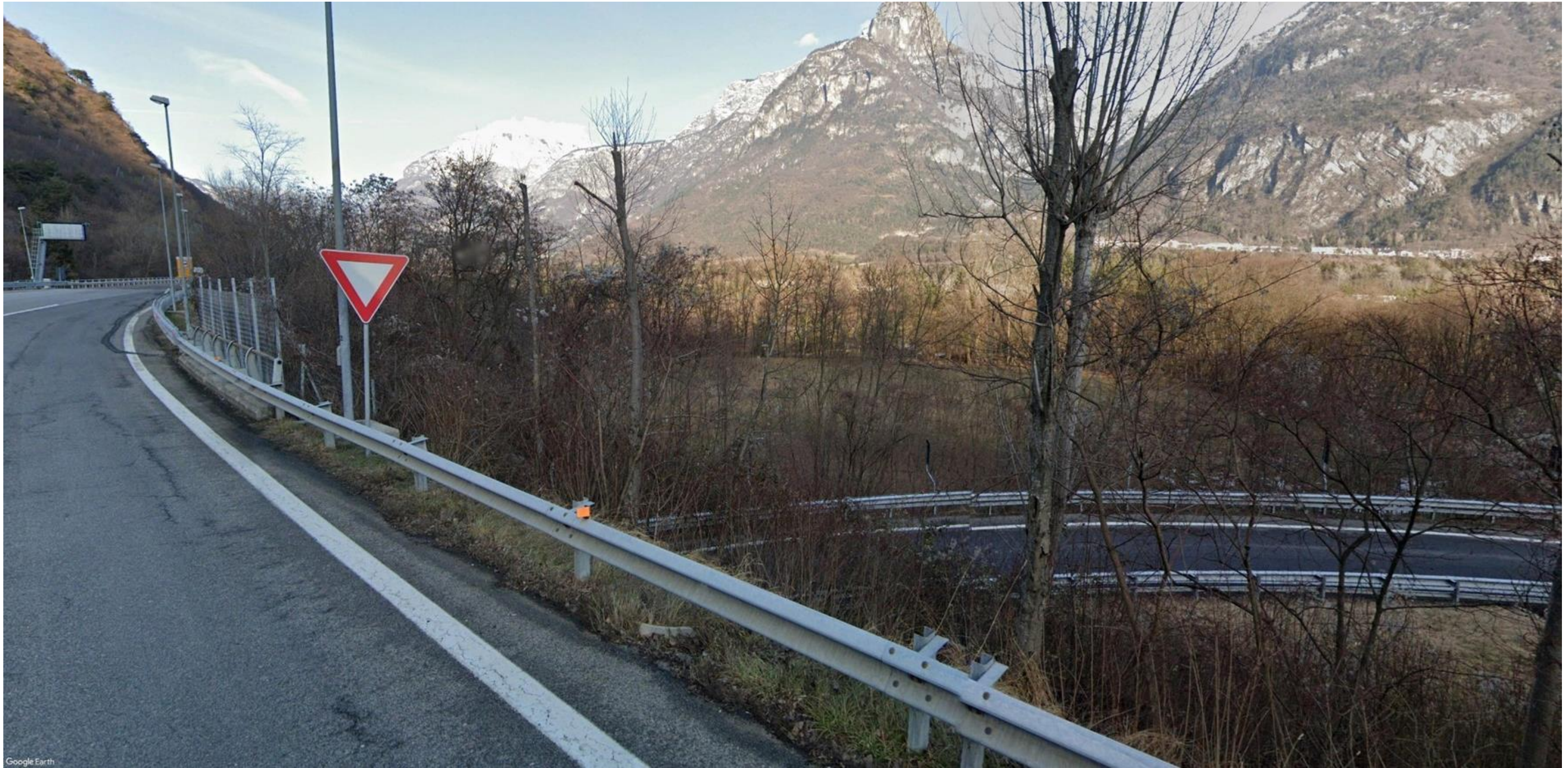
Figura 2: Progressiva 0+600.00 - Vista dall'attuale SS51 oggetto di intervento in direzione NNE. La visuale è rivolta in direzione del Viadotto Frari, che sviluppandosi per circa 440 metri attraversa un'area occupata da una fitta vegetazione. (Fonte: Google Earth)
