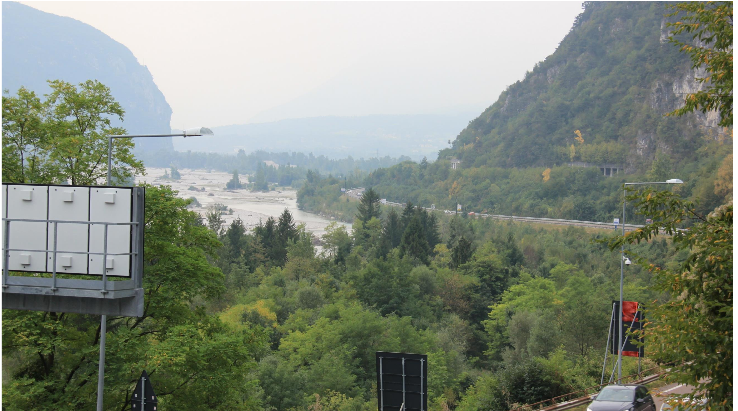
Figura 4: Pk 2+500 - vista dalla strada che raccorda la SS 51 al Viale Vittime del Vajont in direzione Sud. Da questo punto sopraelevato è possibile avere una visuale ampia e rivolta verso l'area d'intervento, dove è previsto un tratto del tracciato in rilevato e a destra del sedime stradale attuale. Sono in primo piano la vegetazione e il Fiume Piave, corso d'acqua vincolato ai sensi dell'articolo 142 del D.Lgs. 42/2004. (Fonte: Sopralluogo)
