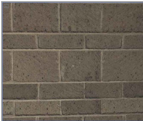
Figura 0-6 Rivestimento in tufo
