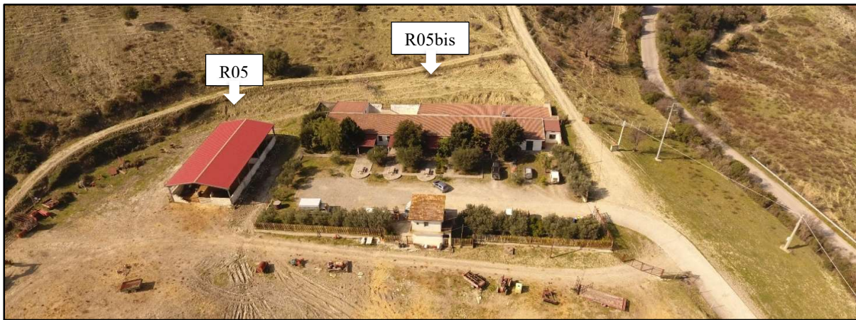
Foto 4a: R05-Non Abitazione; R05bis-Abitazione
