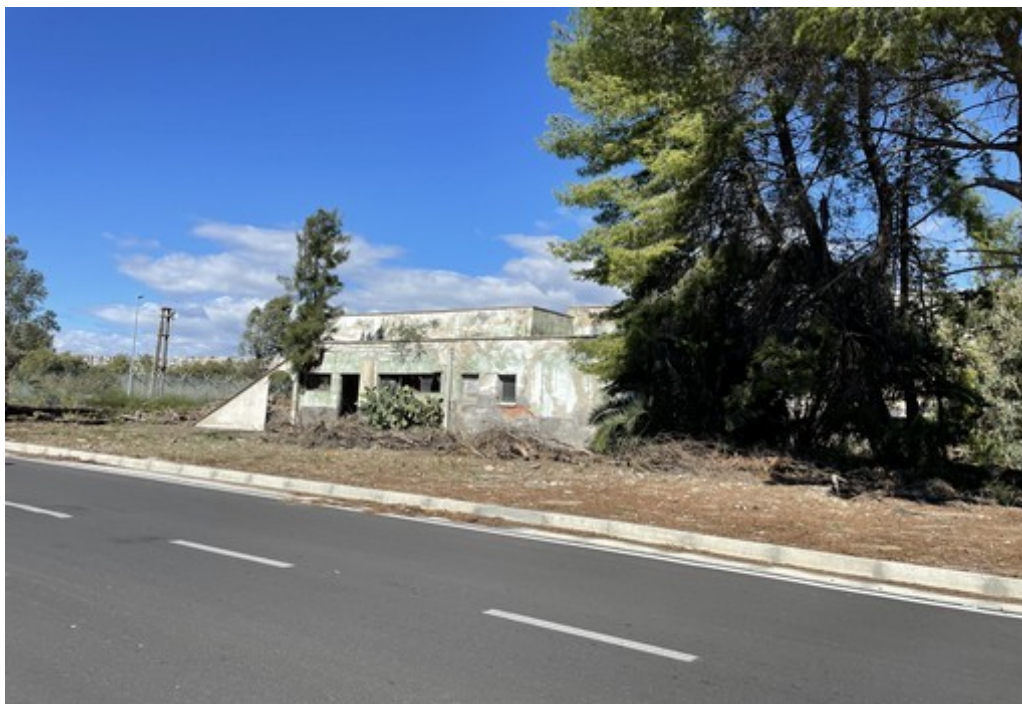
Figura 2.12: edifici fatiscenti abbandonati vicino all'aerostazione (sopralluogo ottobre 2021)
