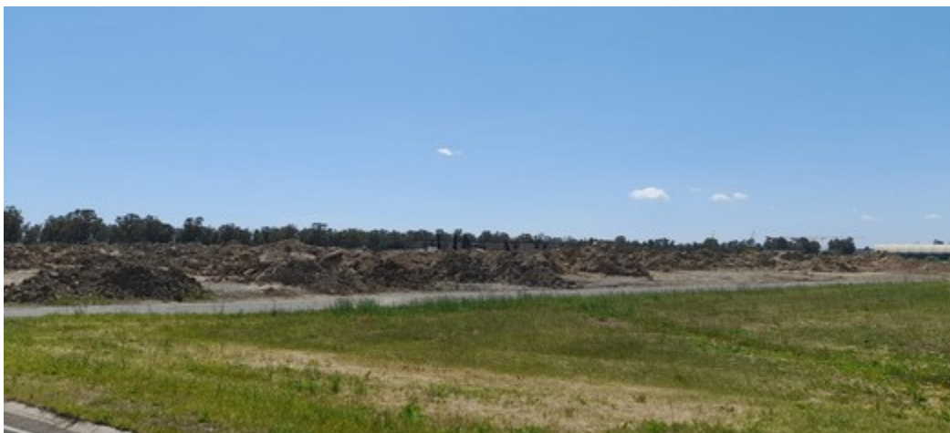
Figura 2.6: Zona di bonifica a sud della pista con riempimento di terreno
