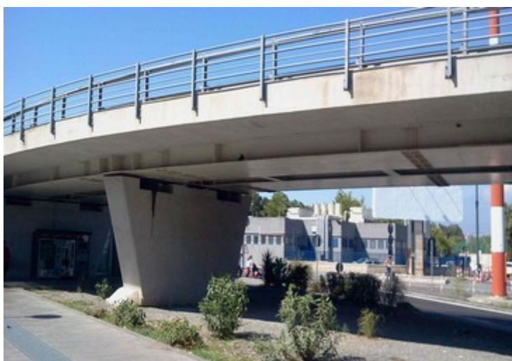
Figura 4.7 viadotto protetto con aghi anti volatili
