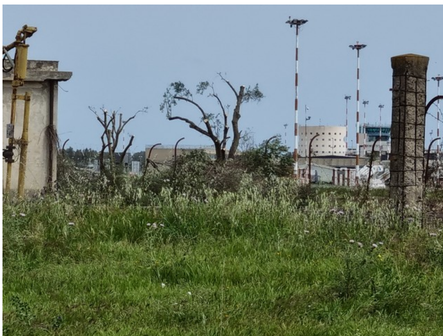
Figura 2.11: potatura ed eliminazione di vegetazione arborea e arbustiva a nord ovest della pista (lato ferrovia)
