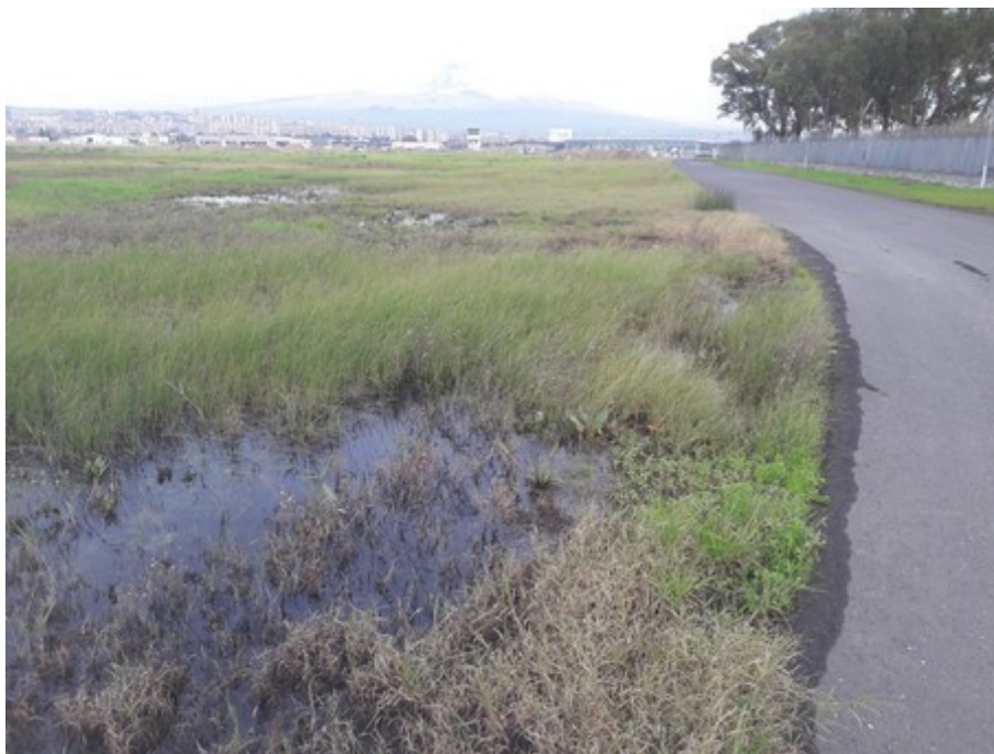
Figura 2.4: aree erbose con presenza di ristagno idrico lungo la perimetrale nella zona a confine con la stazione elicotteri della Marina Militare (MARISTAELI) (sopralluogo dicembre 2021)
