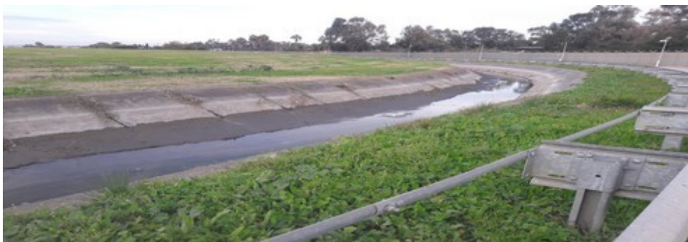
Figura 2.7: Canale di drenaggio presente in testata 26 (sopralluogo dicembre 2021)
