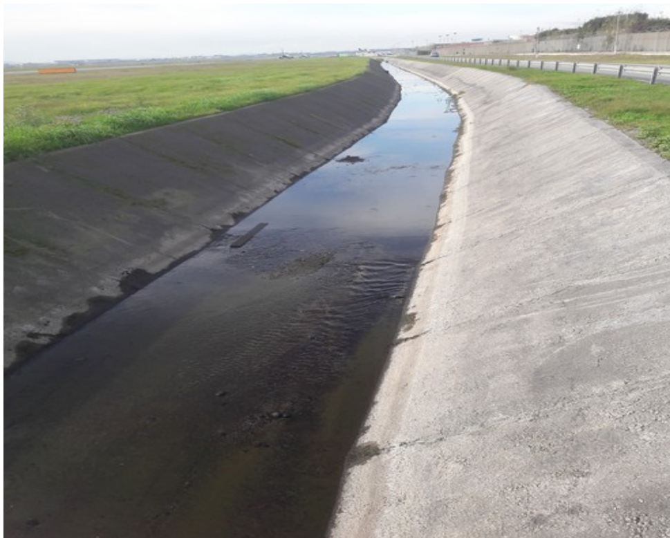
Figura 2.8: Canale di drenaggio in testata 26 (sopralluogo dicembre 2021)
