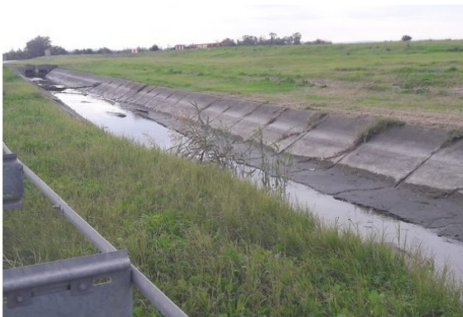
Figura 2.9: canale di scolo presente in testata 26 (sopralluogo dicembre 2021)
