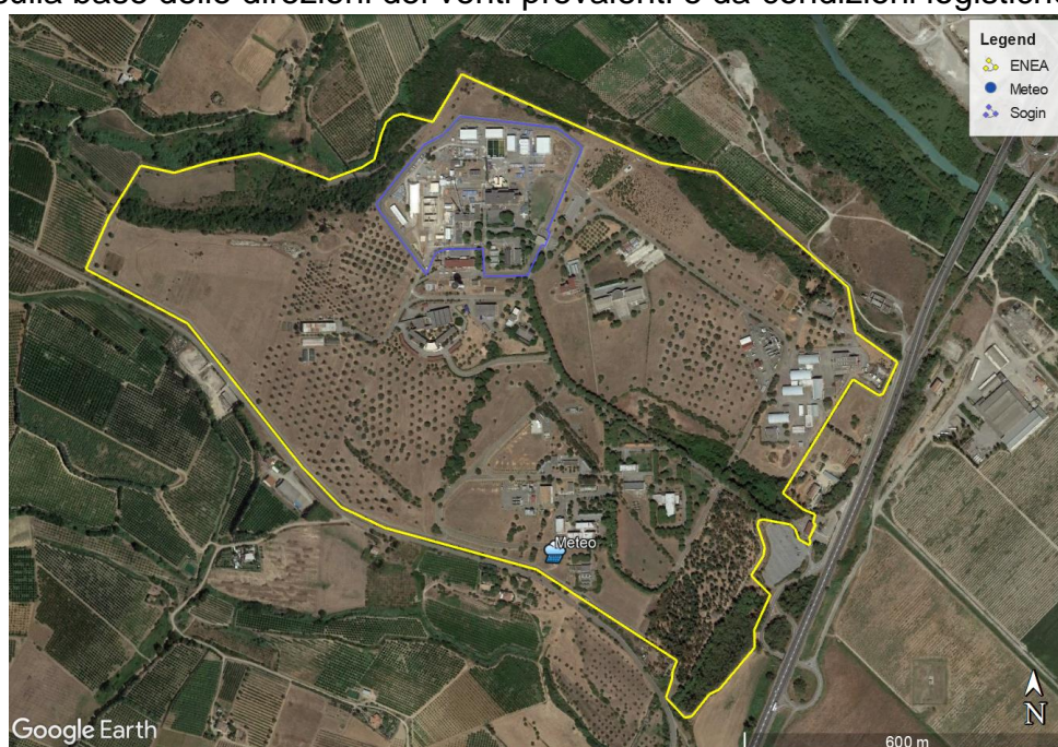
Figura 8.1 - Ubicazione della stazione meteorologica
