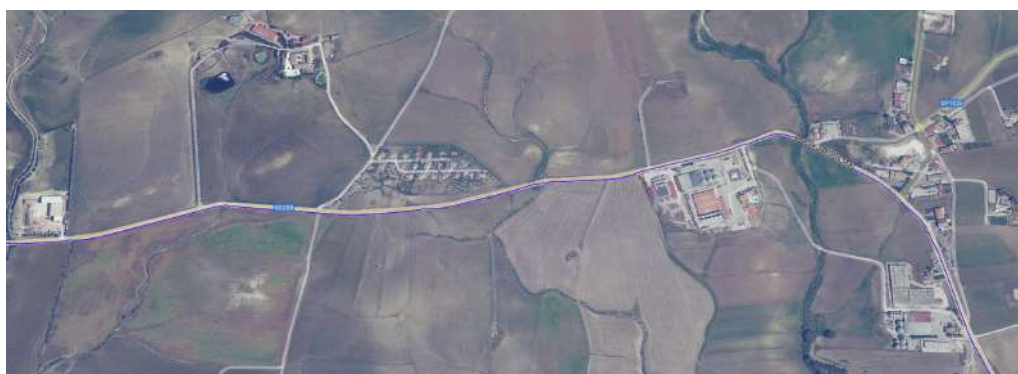
Layout delle aree urbanizzate lungo la strada statale 288 di Aidone
