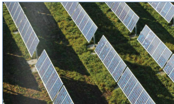
FIGURA 6 : FOTO TIPO TRACKERS AD ASSE VARIABILE
