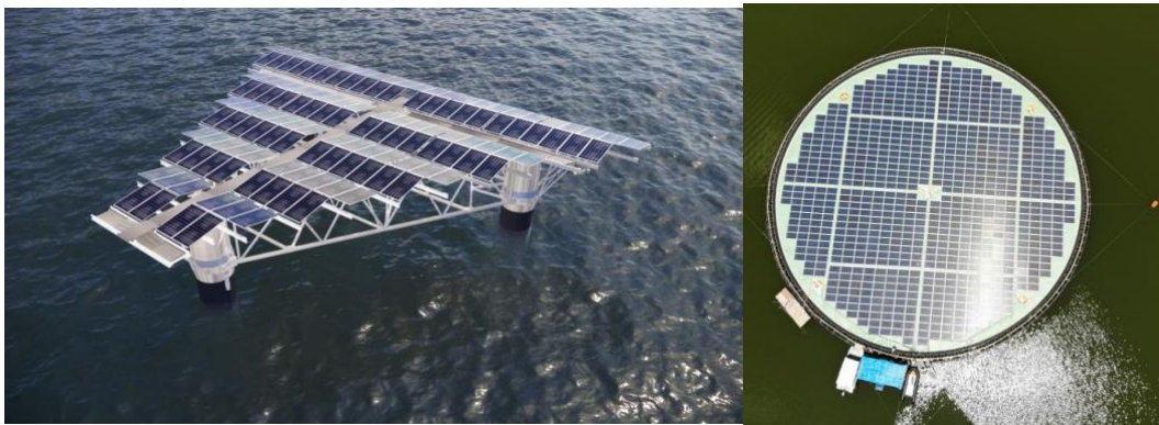
Figura 2: a sx - modulo triangolare della alternativa 1; a dx - modulo circolare della alternativa 2
