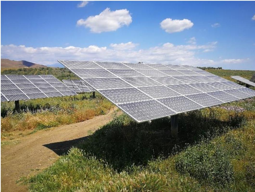
**Figura 6 - Inseguitore biassiale "azimut-elevazione"**
