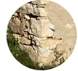
Tessitura muraria costituita da blocchi lapidei semisquadrati in calcarenite, caratteristici del sito di intervento e impiegati prevalentemente per l'ammorsatura dei muri ortogonali.
