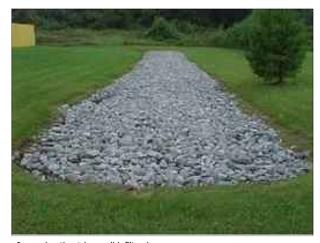
Immagine tipo trinca di infiltrazione
