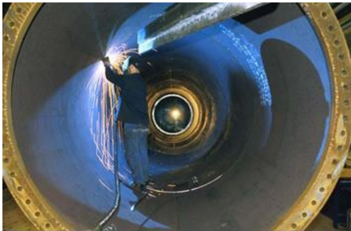
Figura 17: interno di una torre
